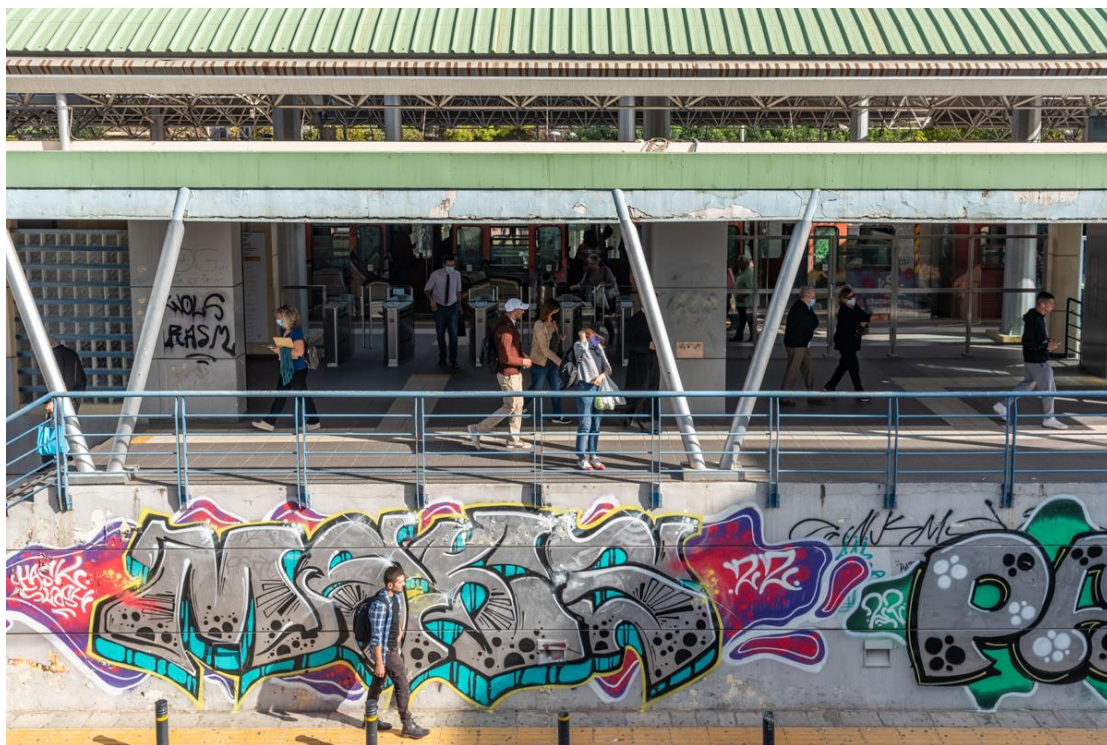
Σταθμός ΗΣΑΠ IV
