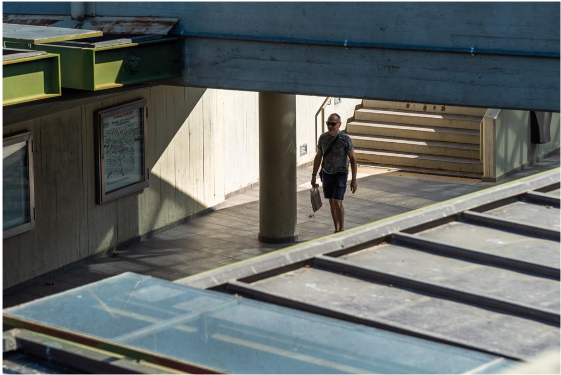
Σταθμός ΗΣΑΠ III
