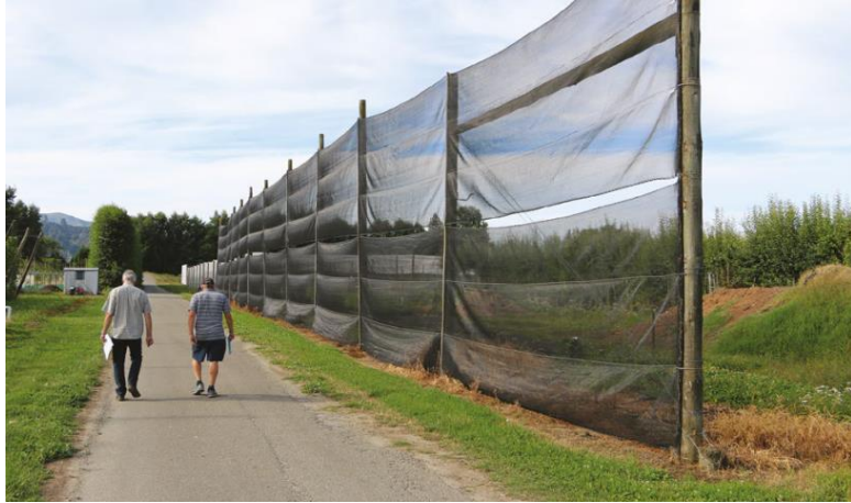
Εικόνα 21. Στύλοι και δικτυωτός ανεμοφράκτης στη πλευρά που είναι απέναντι στη φορά του ανέμου (Dodds, 2017).
