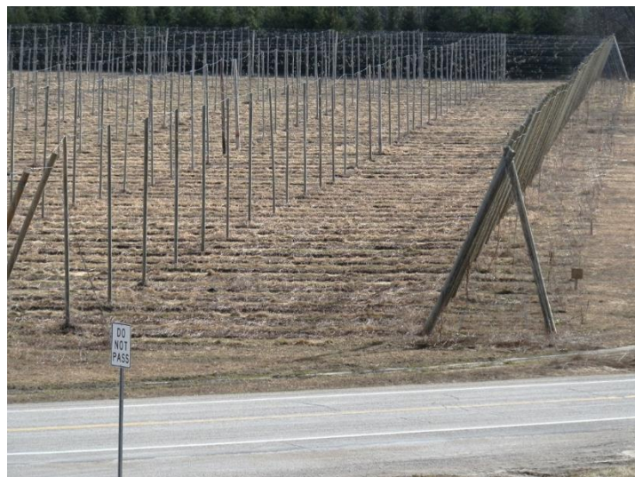
Εικόνα 26. Ακραίοι τεθλασμένοι στύλοι και ευθύγραμμοι στύλοι συστήματος υποστύλωσης λυκίσκου (Fedderson, 2016).
