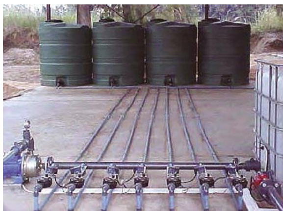
Εικόνα 74. Ένα πιο περίπλοκο σύστημα ικανό να διανέμει πολλαπλά προϊόντα λίπανσης ταυτόχρονα έγχυσης (Dodds, 2017).
