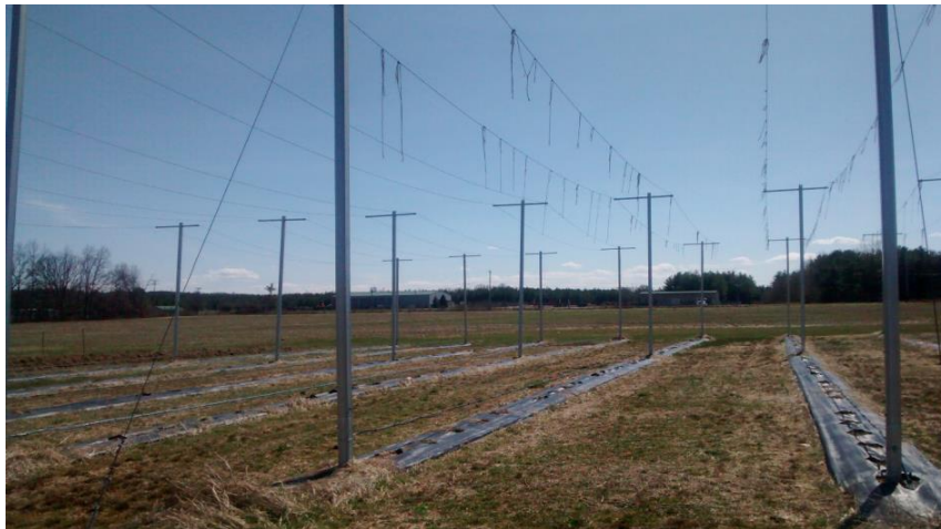
Εικόνα 27. Χαλύβδινο σύστημα υποστύλωσης λυκίσκου (Arnett & Sonco, 2018).
