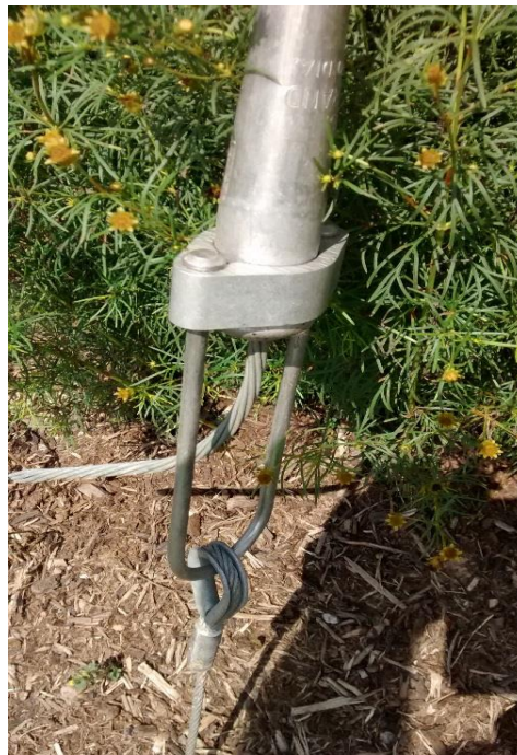
Εικόνα 37. Συσκευή εντατήρα η οποία δεν επιτρέπει στο συρματόσχοινο να κάνει πισωγύρισμα (Arnett & Sonco, 2018).
