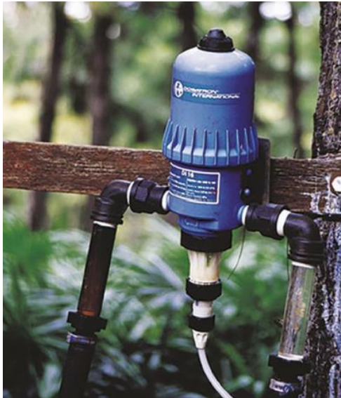
Εικόνα 72. Η άρδευση με ταυτόχρονη λίπανση μπορεί να είναι τόσο απλή όσο μια μονάδα Dosatron® εντός της γραμμής (Dodds, 2017).
