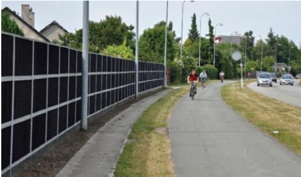
Εικόνα 40: Ηχοπετάσματα από ανακυκλωμένα σύνθετα υλικά, Κοπεγχάγη, Δανία (ΕΛΑΤΑΕΝ, 2020)
