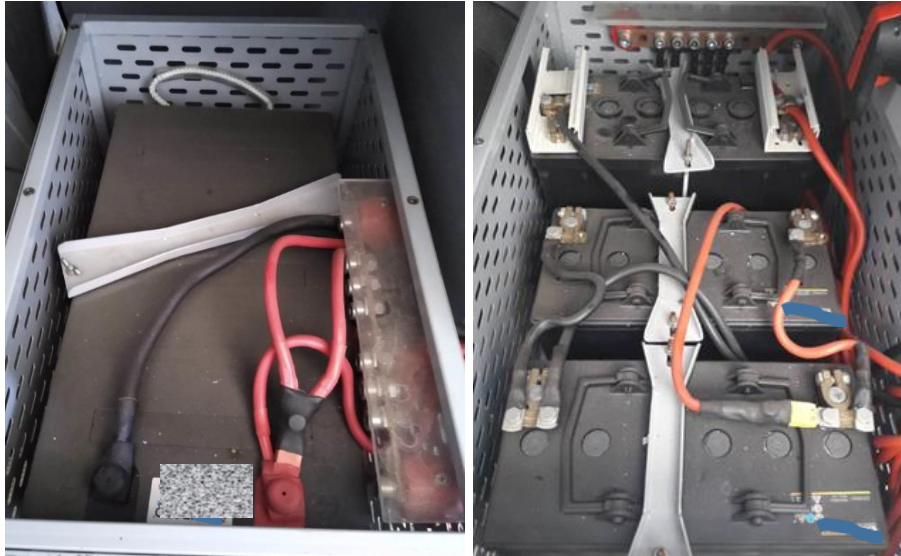
Εικόνα 5-3 Μέρος της συστοιχίας μπαταριών τύπου gel
