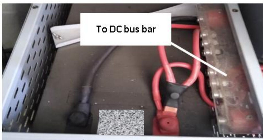
Εικόνα 5-18 Το bus bar των θετικών ακροδεκτών
