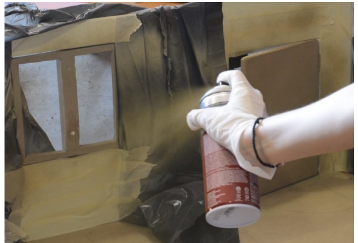
Εικόνα 28. Βάψιμο παραθύρων με σπρέι
