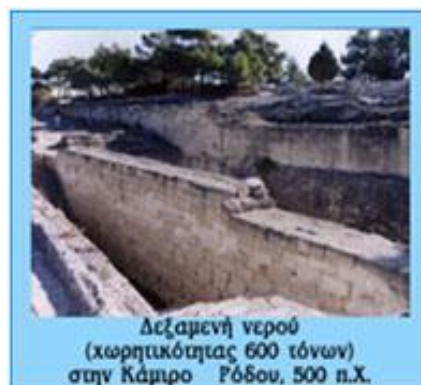
Εικόνα 2 Παράδειγμα εφαρμογής υδραυλικού σκυροδέματος
