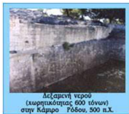
Εικόνα 1 Παράδειγμα εφαρμογής υδραυλικού σκυροδέματος
