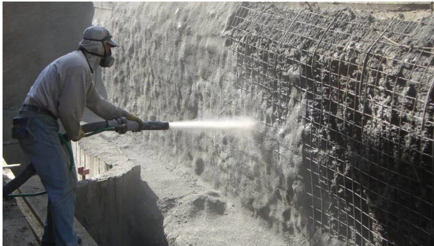
Εικόνα 56 Εφαρμογή ινοπλισμένου εκτοξευόμενου σκυροδέματος
