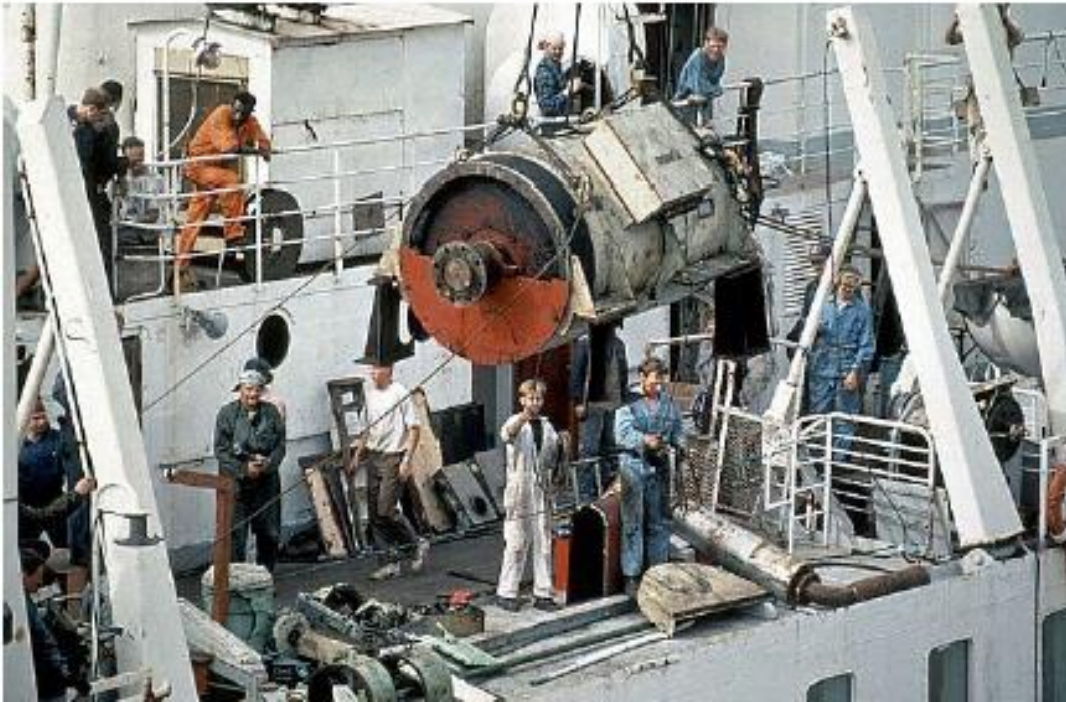
Σχήμα 1.3: Αντικατάσταση παλιάς γεννήτριας DC
