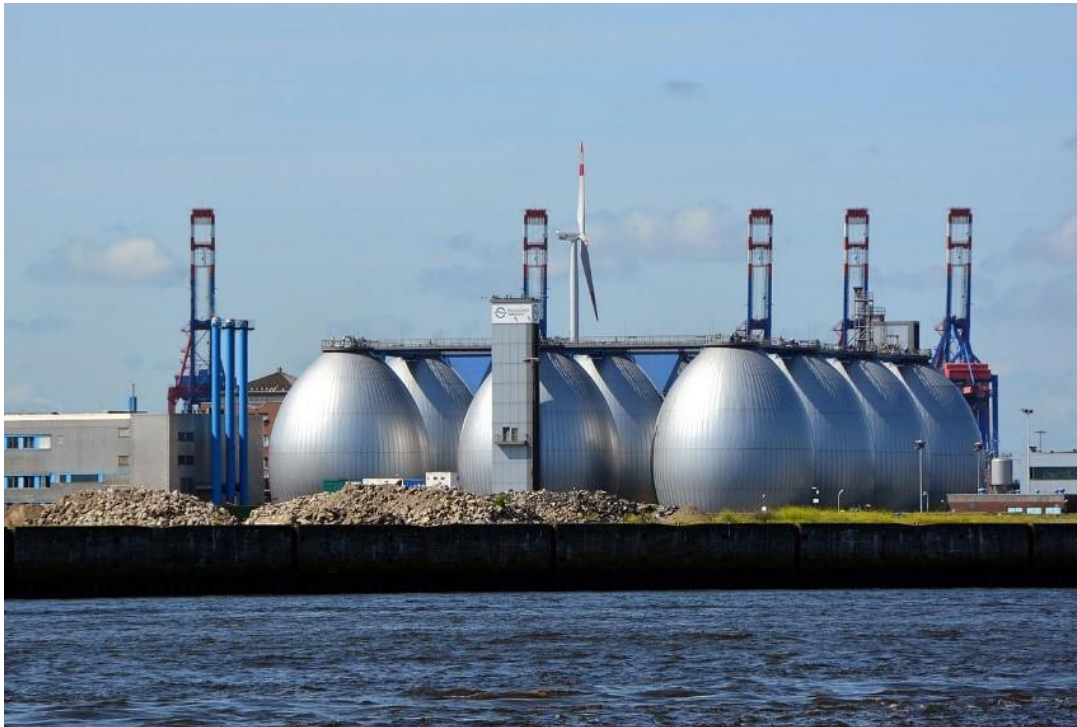
Εικόνα 4: Η μονάδα επεξεργασία αποβλήτων του Αμβούργου (πηγή: Ευρωπαϊκή Τράπεζα Επενδύσεων)
