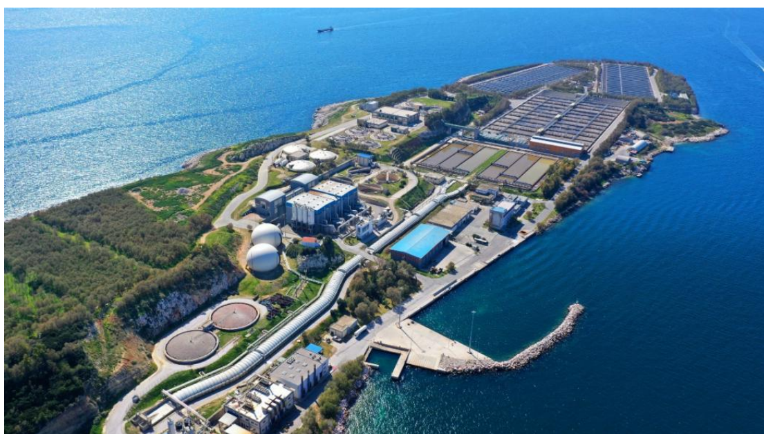
Εικόνα 15: Άποψη της μονάδας επεξεργασίας υγρών αποβλήτων στην Ψυττάλεια (πηγή: διαδίκτυο)
