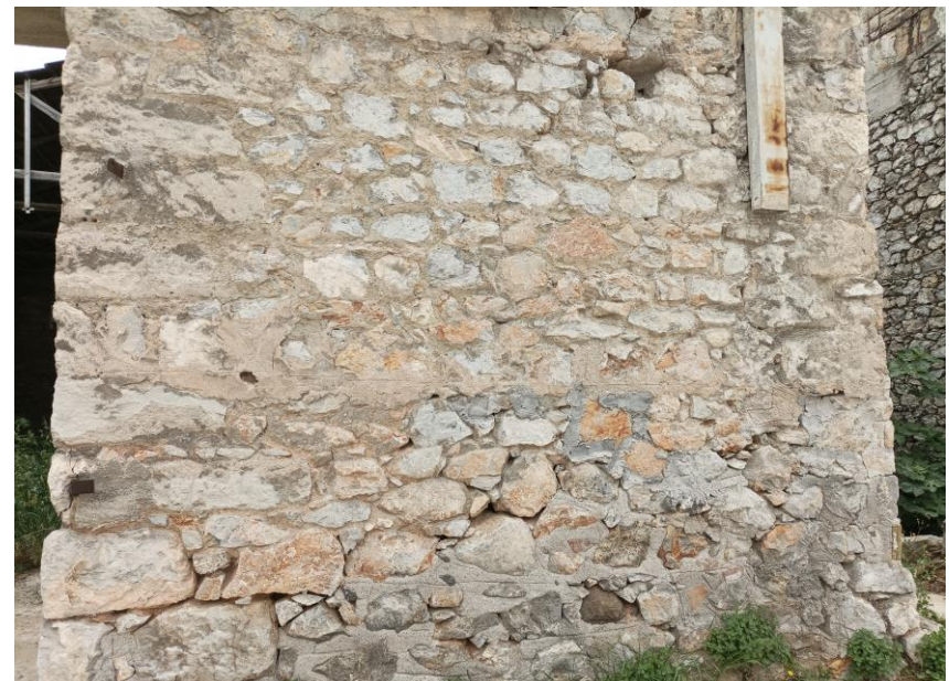
Εικ.25 Λεπτομέρεια λιθοδομής
