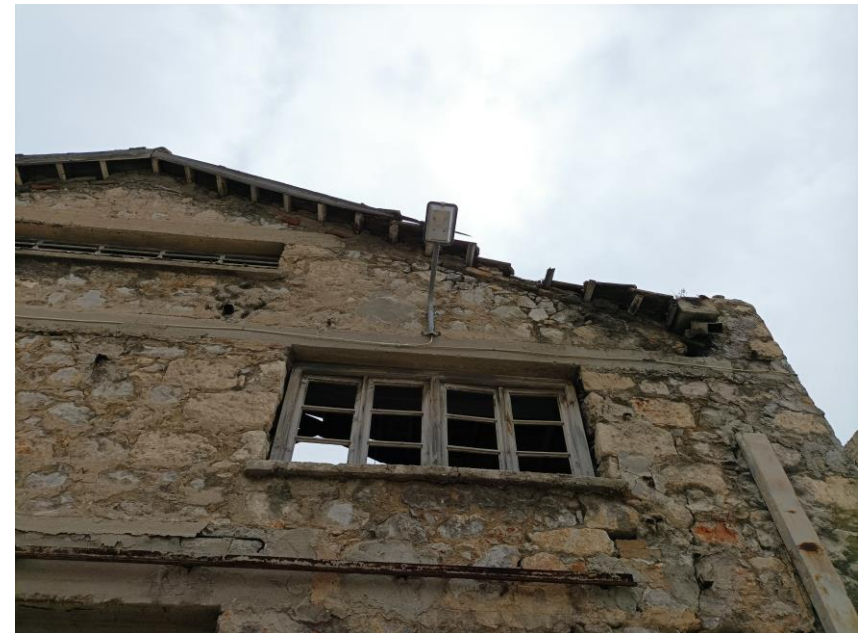
Εικ.23 Λεπτομέρεια ξύλινου κουφώματος
