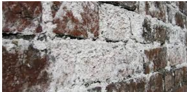
Εικ. 1.4.11: Εξανθήσεις λόγω στερέωσης με Portland ( http://dripdropstop.com.au/ )
