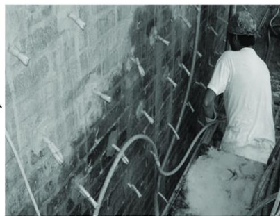
Εικ. 1.4.10: Διοχέτευση στερεωτικού ενέματος σε τοιχοποιία (L. Baltazar et al. , (2019), https://www.researchgate.net/ )
