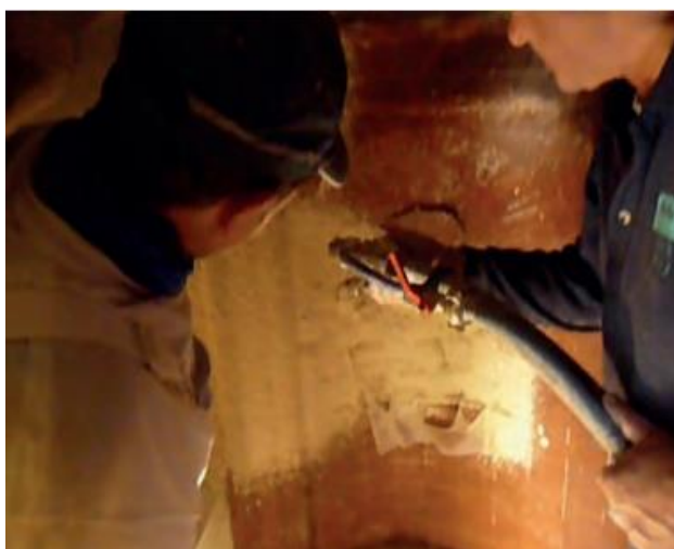
Εικ. 3.2.5: μηχανική εφαρμογή πολτού με ψεκασμό (Pater, 2021)
