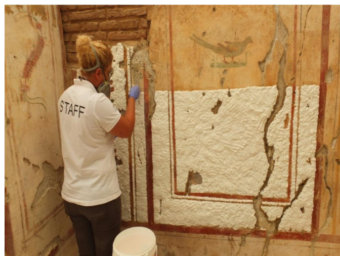
Εικ. 3.2.6: χειροποίητη εφαρμογή του πολτού (Escisi&CaglarEryurt, 2019)
