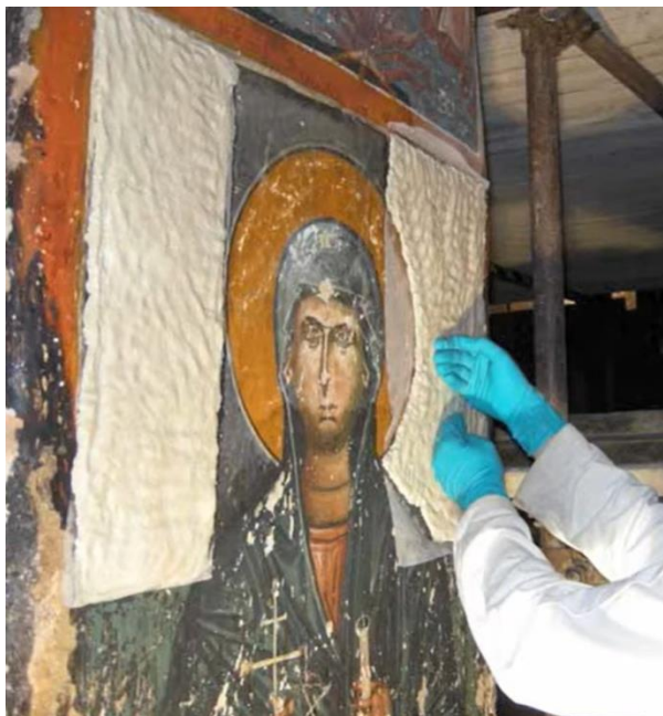
Εικ. 3.2.1.3: Εφαρμογή χαρτοπολτού σε τοιχογραφία ( https://courtauld.ac.uk/ )
