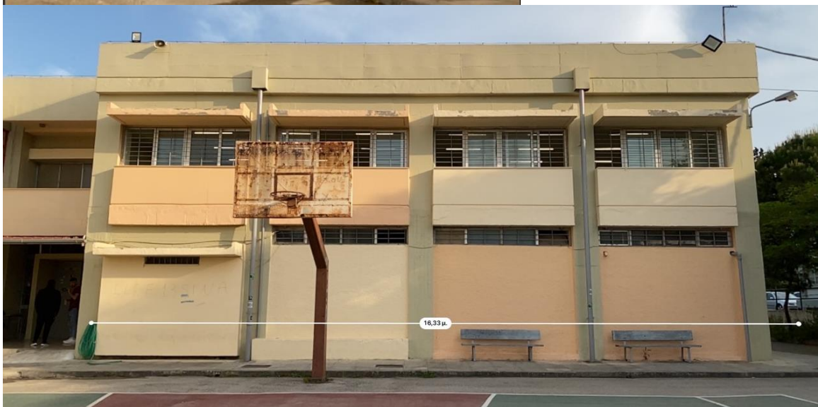
Εικόνα 13 : Βόρεια Πλευρά Πίσω Όψη
