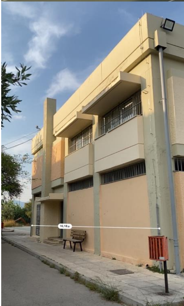
Εικόνα 14: Δυτική Πλευρά Πλάγια Αριστερή Όψη
