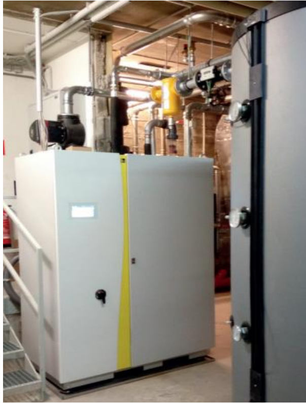
Σχήμα 4. 17: Αντλίας Θερμότητας TERRA SW MAX H140 [37]
