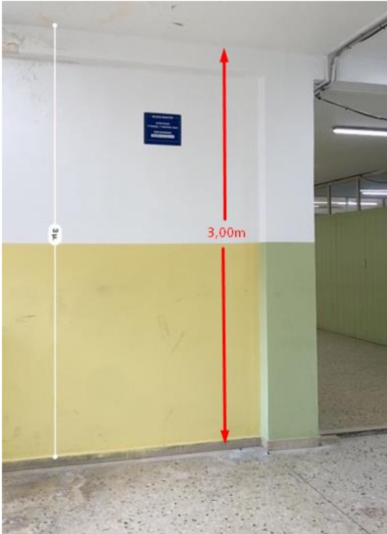
6 Καταμέτρηση Ύψους Ισογείου
