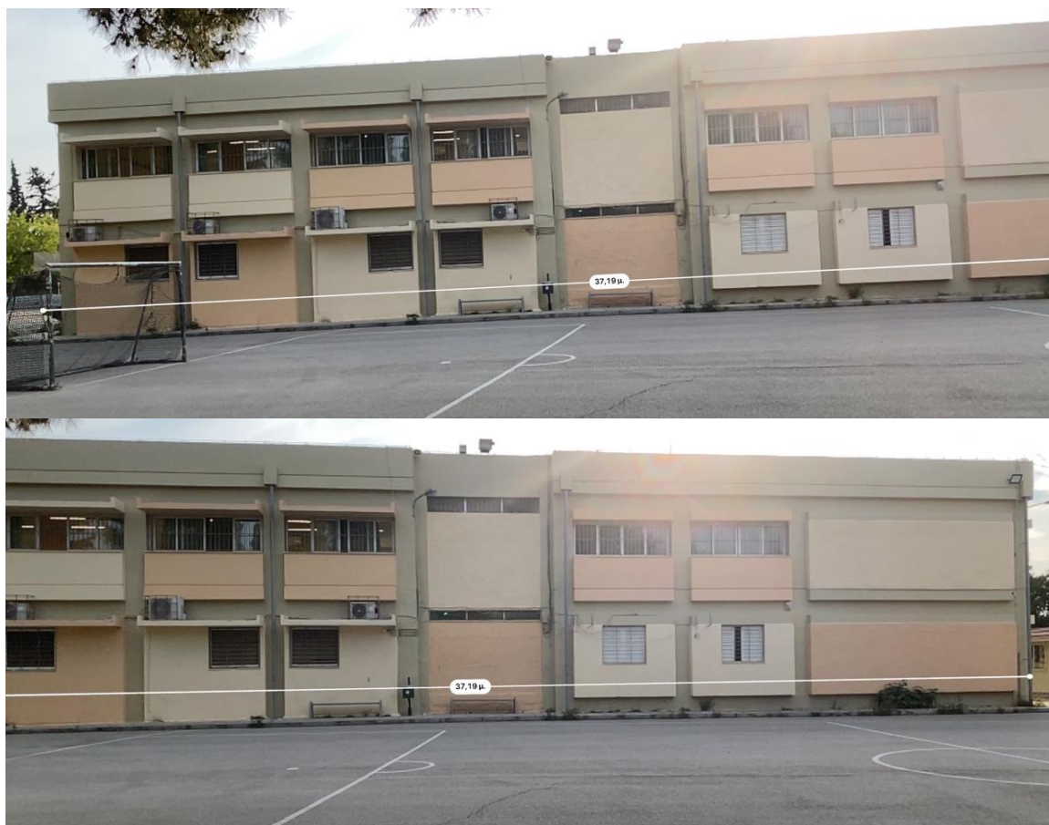
Εικόνα 16: Ανατολική Πλευρά Πλάγια Δεξιά Όψη
