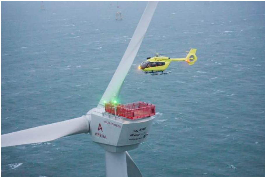
Εικόνα 4.20: Υπεράκτια Α/Γ με πλατφόρμα υποστήριξης ελικοπτερου [55]
