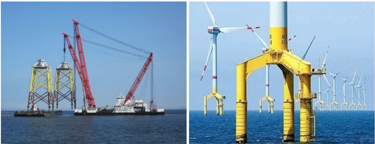
Εικόνα 4.8: Τοποθέτηση θεμελίωσης τύπου δικτυώματος στο ΥΑΠ Ormonde της Ιρλανδίας και θεμελιώσεις τριπλού πυλώνα στο ΥΑΠ Bard της Γερμανίας [40], [41]
