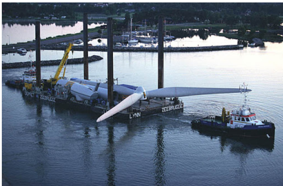
Εικόνα 4.19: Μεταφορά προσυναρμολογημένου ρότορα (διαμέτρου 70 m) προς τοποθέτηση στο ΥΑΠ Yttre Stengrund της Σουηδίας (δεν βρίσκεται πλέον σε λειτουργία καθώς το 2015 έγινε το 1ο αποσυρθέν ΥΑΠ στον κόσμο) [54]
