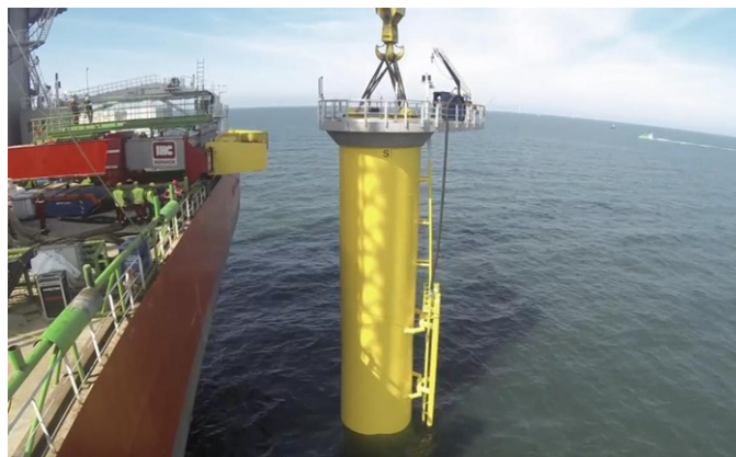
Εικόνα 4.6: Τοποθέτηση μονού πυλώνα στο ΥΑΠ Borkum Riffgrund 1 της Γερμανίας [38]
