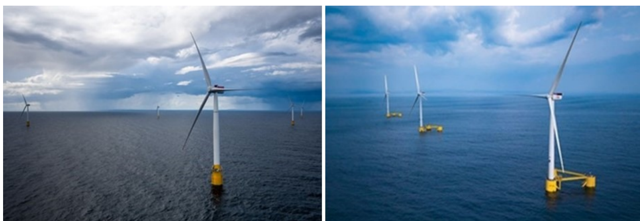
Εικόνα 4.10: Πλωτό ΥΑΠ Hywind Scotland της Σκωτίας (το 1ο πλωτό ΥΑΠ στην ιστορία) και πλωτό ΥΑΠ WindFloat Atlantic της Πορτογαλίας (το μεγαλύτερο πλωτό ΥΑΠ στον κόσμο την παρούσα στιγμή) [44], [45]
