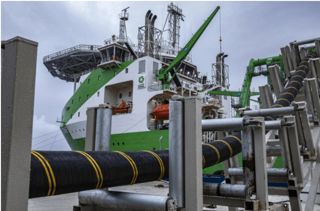
Εικόνα 4.18: Ανάπτυξη του υποβρύχιου καλωδίου προς τοποθέτηση στο YAPI SeaMade του Βελγίου [53]
