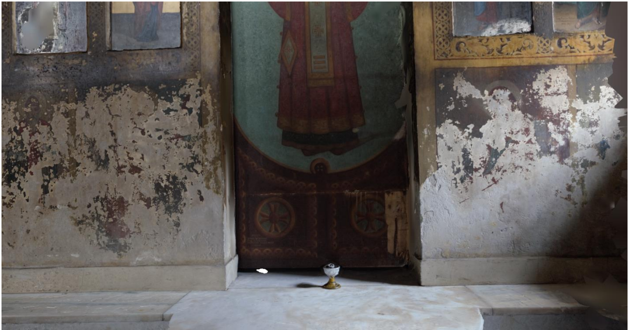
Εικόνα 4.16: Απώλειες χρωματικού στρώματος στο τέμπλο του ναού. Φωτογραφία από το Recar Photo.
