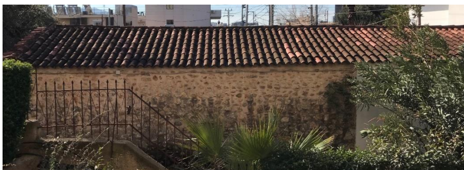
Εικόνα 5.8: Η βόρεια όψη του ναού όπου φαίνονται και οι δύο τοιχοποιίες.
