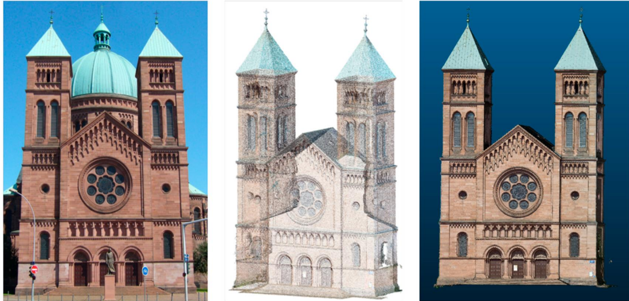
Εικόνα 6.9: (a) Φωτογραφία της πρόσοψης, (b) Το point cloud, (c) το mesh του ναού του St-Pierre-le-Jeune (Yang et al. , 2019).
