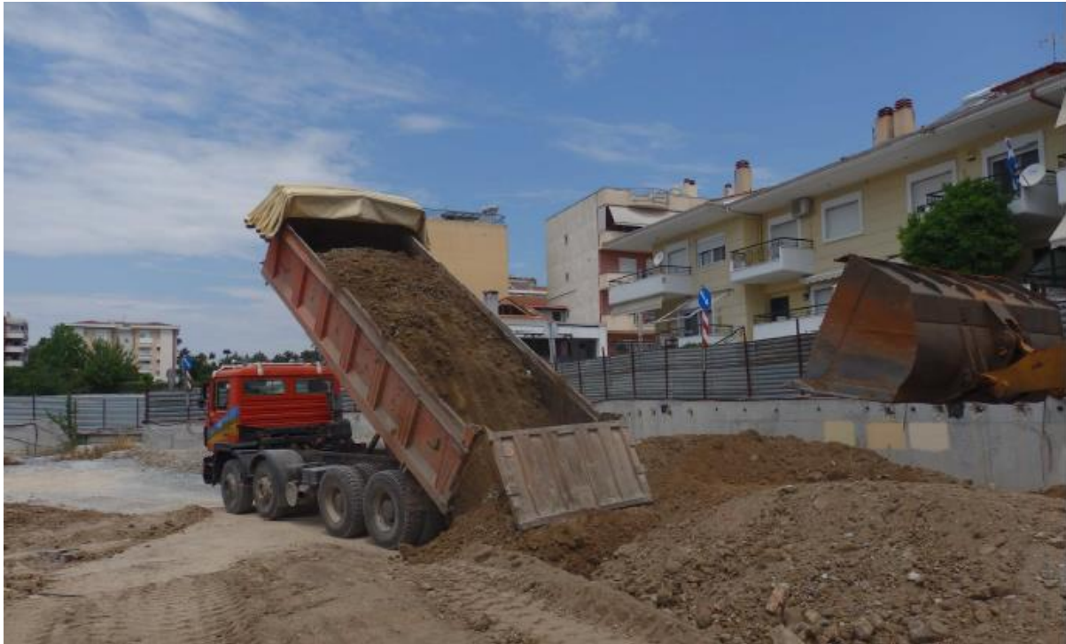
Εικόνα 3: Ελεγχόμενη απόθεση πλεονάζοντος εδαφικού υλικού.
