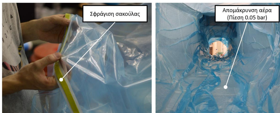
Εικόνα 112. Κατασκευή σακούλας και εφαρμογή κενού αέρος στο εσωτερικό της (Πίεση 0.05 bar)
