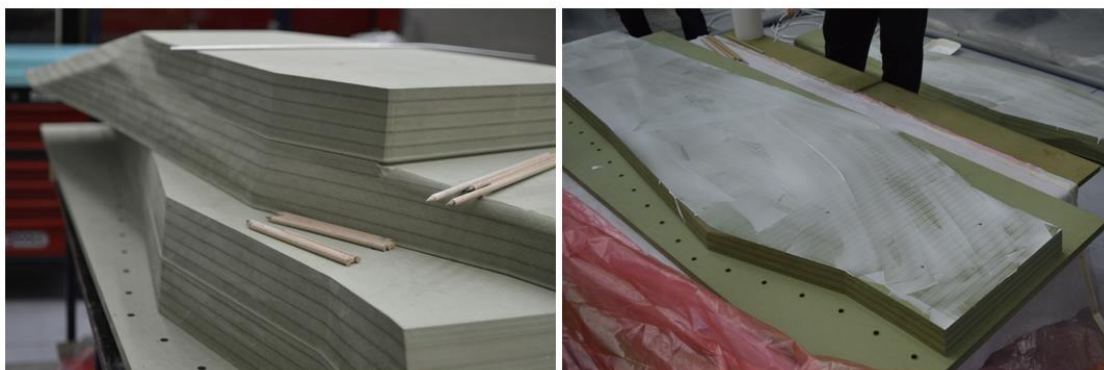
Εικόνα 98. Κατασκευή αρσενικών καλουπιών
