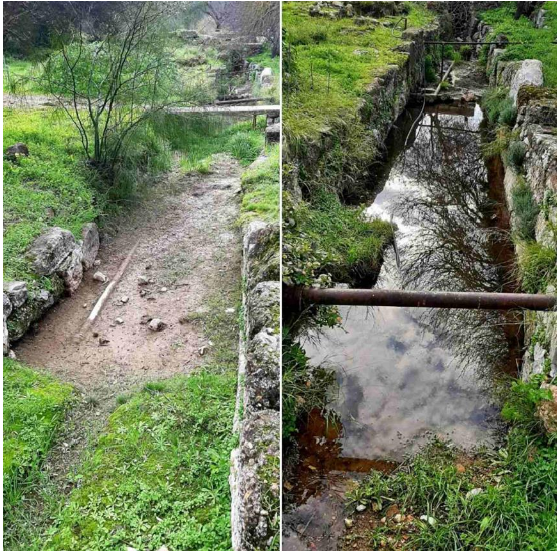
Εικόνα 169: Τμήμα ρέματος & Σιδερένιων αγωγών εντός της αρχαίας αγοράς Θησείου
