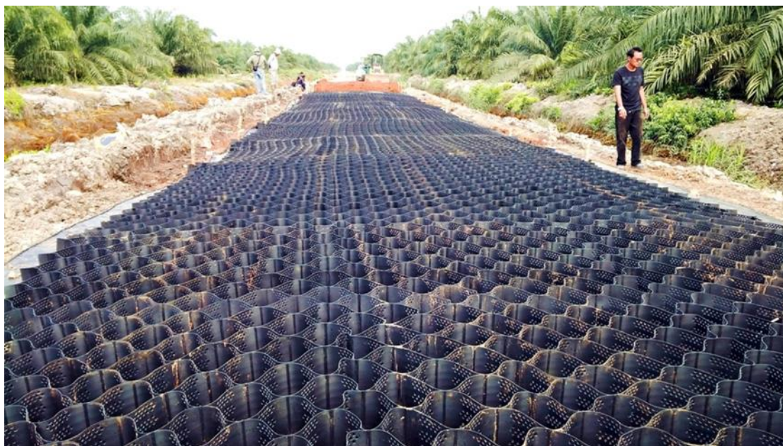
Εικόνα 38: Εφαρμογή των τρισδιάστατων γεωσυνθετικών κυψελών
