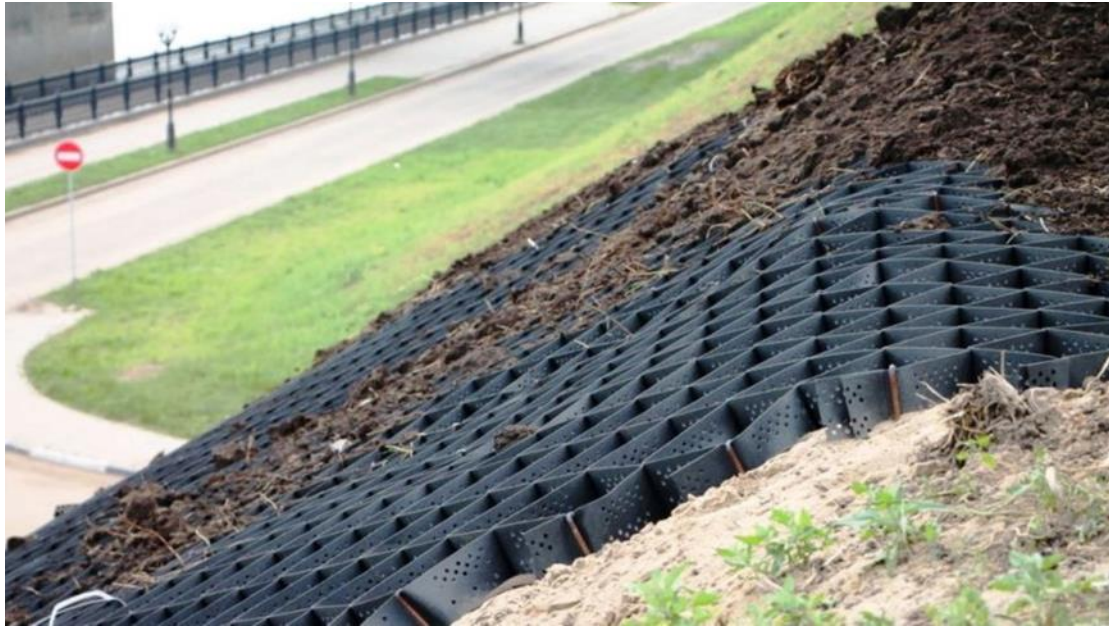
Εικόνα 35: Εφαρμογή των τρισδιάστατων γεωσυνθετικών πλεγμάτων
