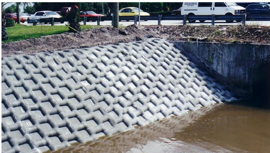
Εικόνα 39: Εφαρμογή ζεύγος γεωφάσματος με σκυρόδεμα.
