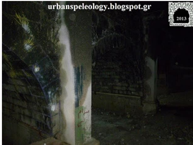
Εικόνα 122: Εσωτερικά με τσιμεντένια υποστυλώματα
