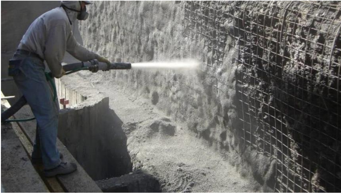
Εικόνα 34: Εφαρμογή του εκτοξευμένου σκυροδέματος
