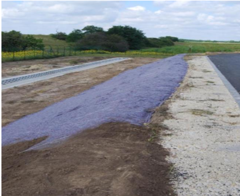
Εικόνα 36: Εφαρμογή των τρισδιάστατων βιοδιασπώμενων ταπήτων
