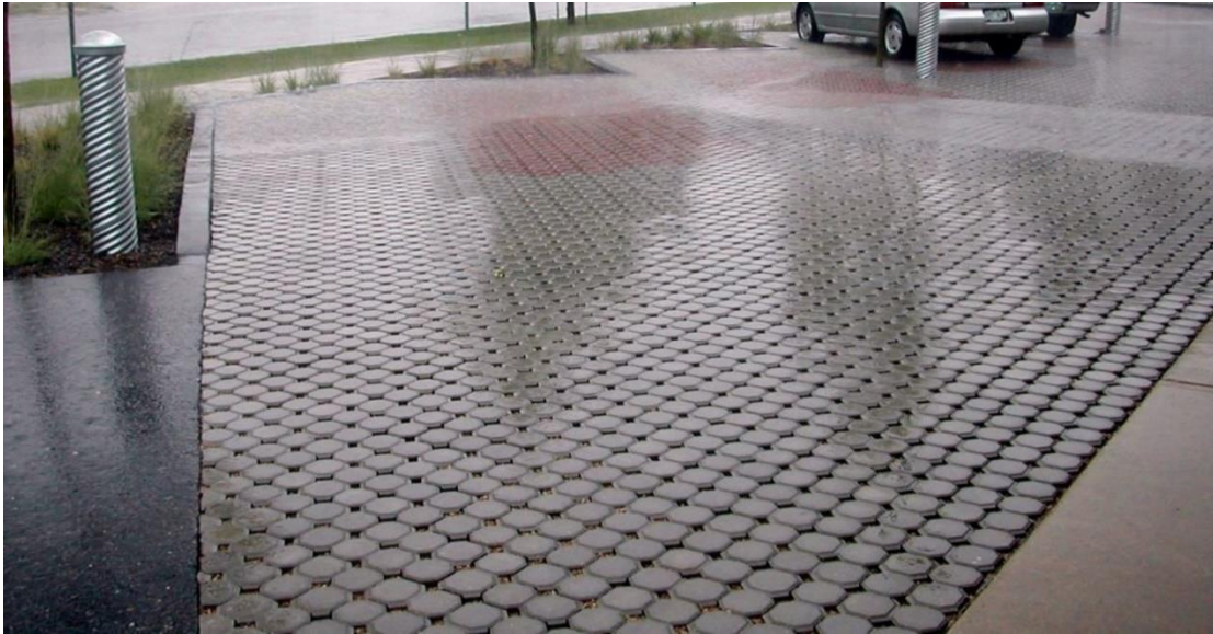
Εικόνα 7: Διαπερατή πλακόστρωση (permeable paving)
