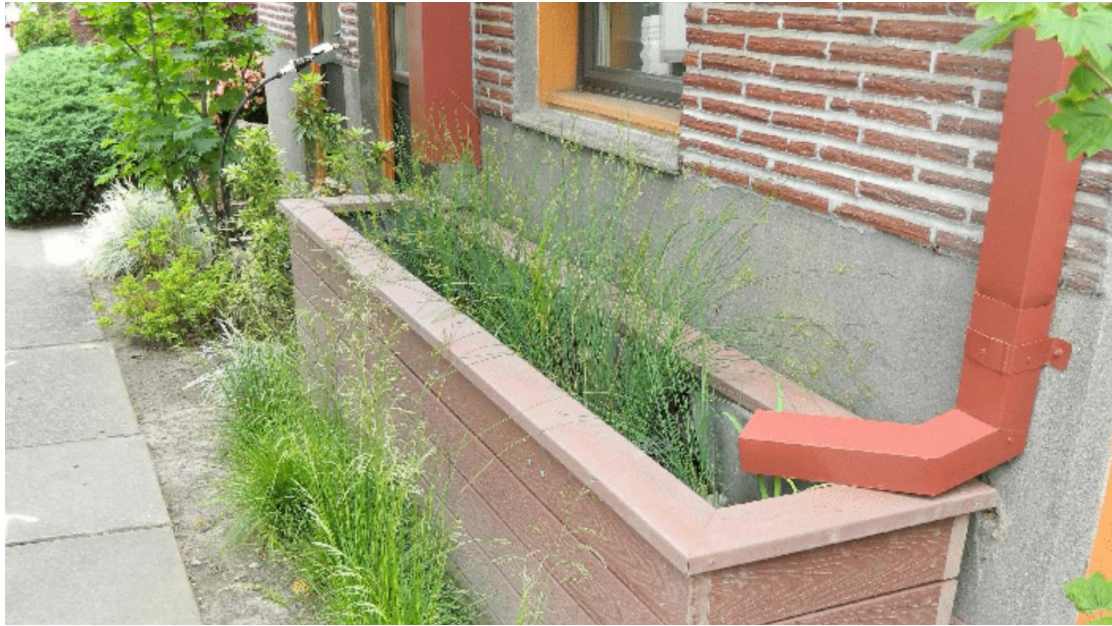
Εικόνα 10: Αποσύνδεση εκροής (downspout disconnection)
