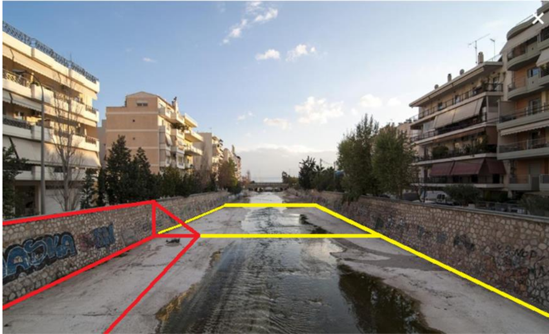
Εικόνα 148: Εσωτερικό ορατό τμήμα κοίτης του ποταμού Ιλισσού
