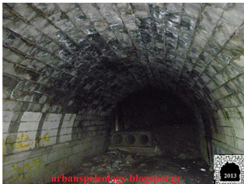
Εικόνα 123: Φαρδιοί σωλήνες εντός της δεξιάς κάμαρας
