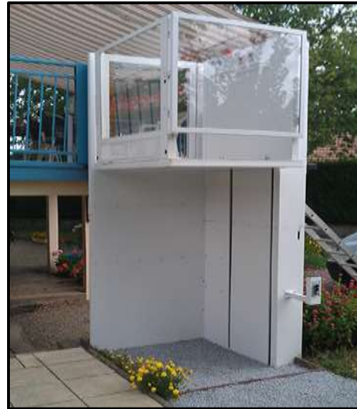
Εικόνα 8. Ανελκυστήρας τύπου πλατφόρμας.
