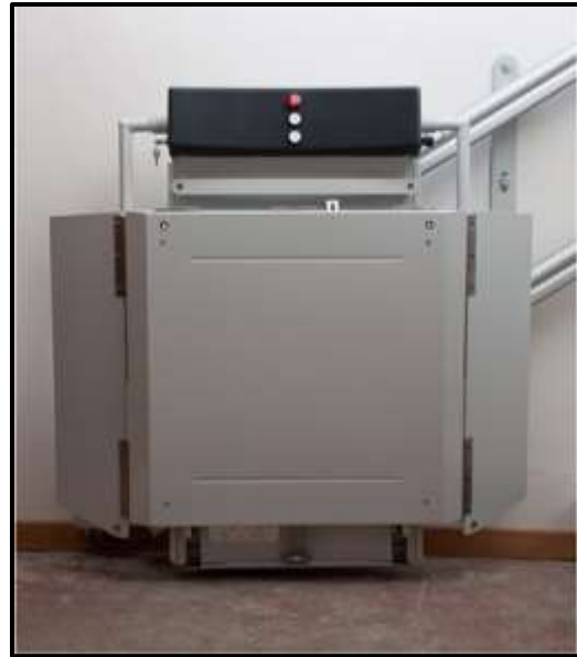
Εικόνα 12. Ανοικτή πλατφόρμα ανελκυστήρα σκάλας. Εικόνα 13. Κλειστή πλατφόρμα ανελκυστήρα σκάλας.
