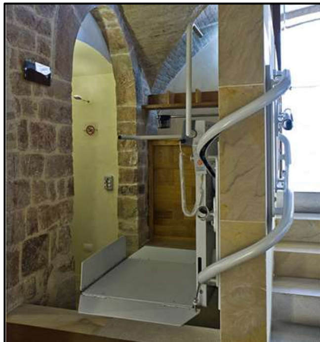
Εικόνα 14. Ανοικτή πλατφόρμα ανελκυστήρα σκάλας (στροφή ράγας).
