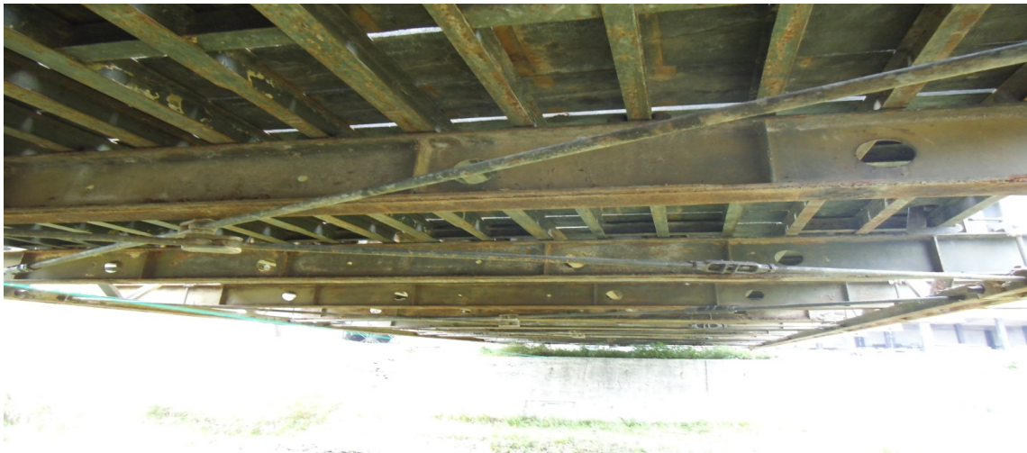
Figure 9 Λεπτομέρεια σύνδεσης αντιανέμιων συνδέσμων
