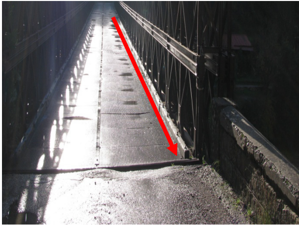
Figure 7 Αυτοσχεδίες Επιζυγίδες σε Τριπλό-Διπλό Φορέα στο Θέρμο Αιτωλοακαρνανίας
