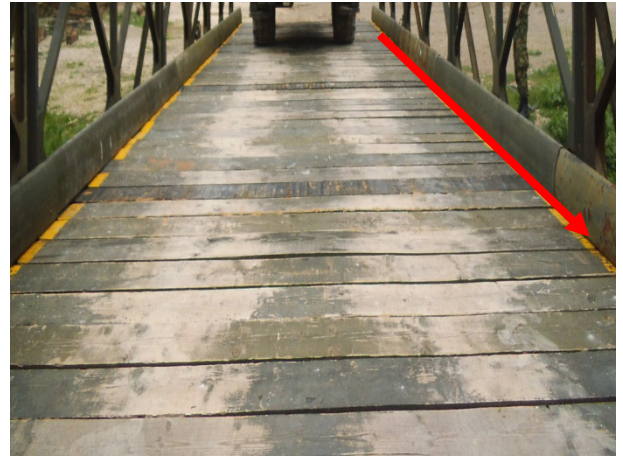
Figure 8 Κατάστρομα με επιζυγίδες της συλλογής γέφυρας Bailey
