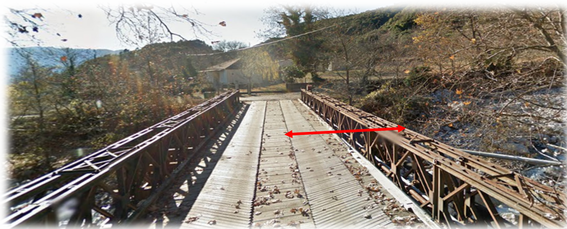
Figure 12 Ωφέλιμο πλάτος γέφυρας 3,81 m
