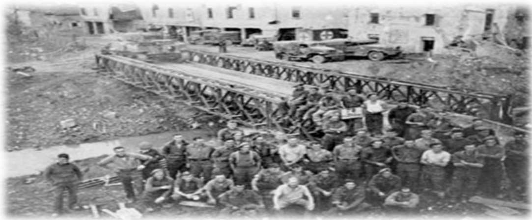
Figure 1 Απλός Φορέας γέφυρας Bailey πάνω από το Ρέμα Riggosa κοντά στη Gambetolla κατελκούμενος από Λόχο Σακαπανένων των Συμμαχικών Δυνάμεω
