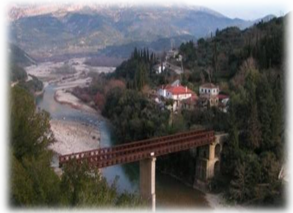
Figure 4 Η γέφυρα του Θέρμου πριν την τοποθέτηση του μεσοβάθρου Figure 5 Η γέφυρα μετά την τοποθέτηση μεσοβάθρου
