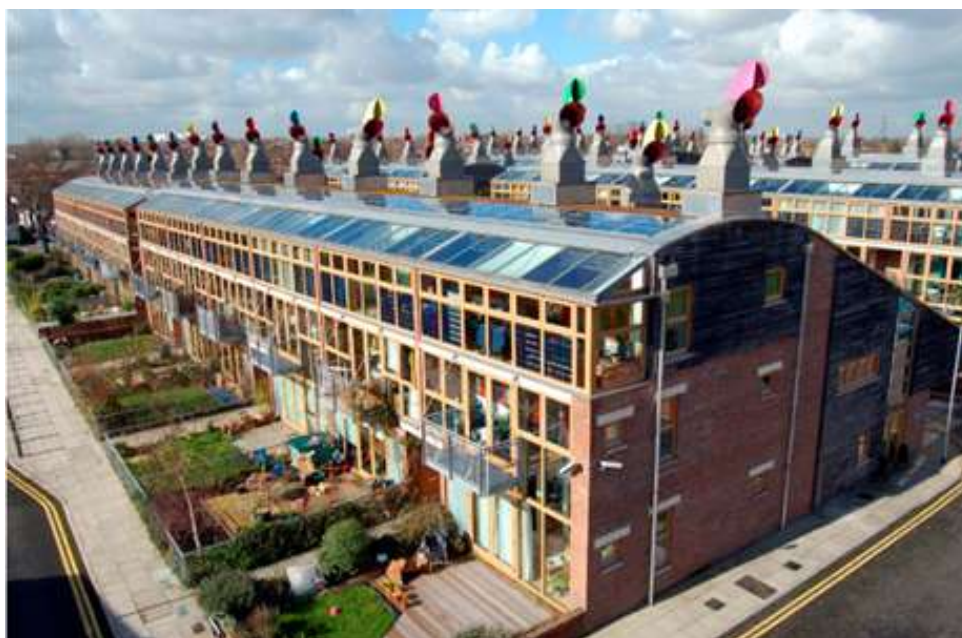
Εικόνα 1: Κτιριακό συγκρότημα στο Λονδίνο (2002) που καλύπτεται αποκλειστικά με χρήση ΑΠΕ και επίσης έχει μηδενικό αποτύπωμα άνθρακα.
