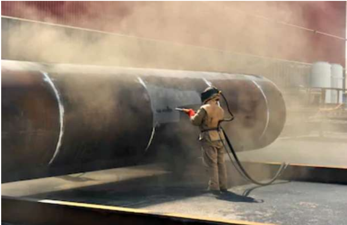
Εικόνα 4. Καθαρισμός μεταλλικής επιφάνειας με αμμοβολή. Πηγή: https://dalco.ca/conventional-abrasive-blasting/
