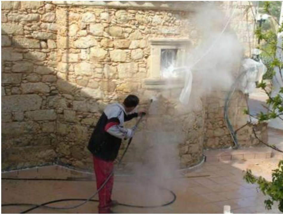
Εικόνα 3.Εφαρμογή Υδροβολής σε πέτρα (Πηγή: https://m.facebook.com/pg/HouseService-136178566455287/photos/ )
