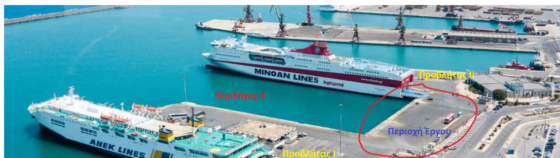
Εικ. 11 Η περιοχή εκτέλεσης των έργων στην σημερινή της μορφή.
