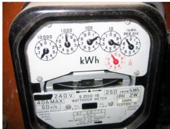
Εικόνα 8: Μονοφασικός ηλεκτρομηχανικός αναλογικός μετρητής με έξι αθροιστικές βαθμίδες ένδειξης[20]
