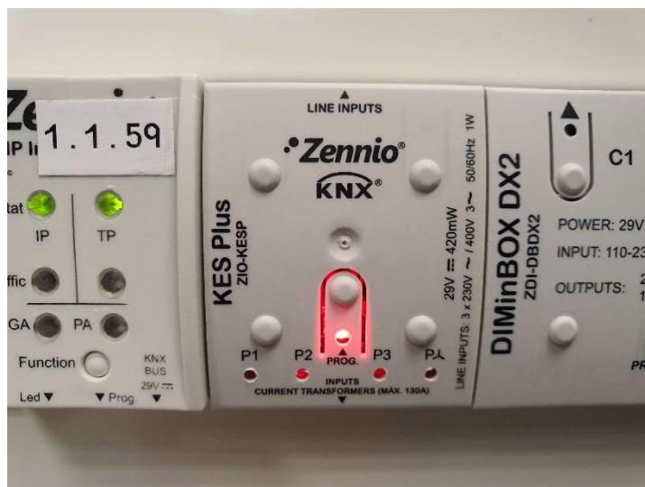
Εικόνα 55: Ψηφιακός τριφασικός μετρητής τεχνολογίας KNX Zennio μοντέλο KES Plus
