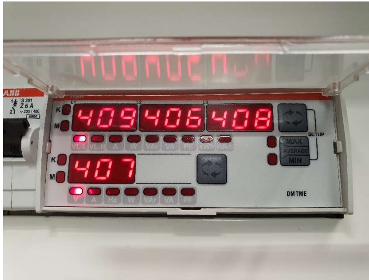
Εικόνα 52: Ψηφιακός τριφασικός μετρητής πίνακα ABB μοντέλο DMTME
