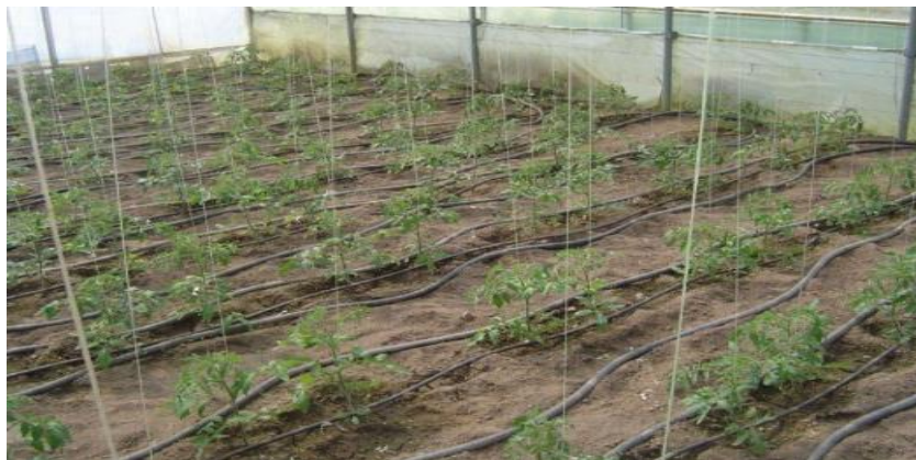
Εικόνα 26: Επιδαπέδιοι σωλήνες θέρμανσης PE [Πηγή: 37]
