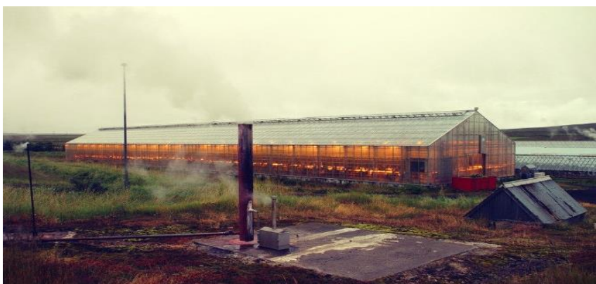
Εικόνα 5: Θέρμανση θερμοκηπίου με γεωθερμική πηγή, ( https://www.graithros.gr/ )
