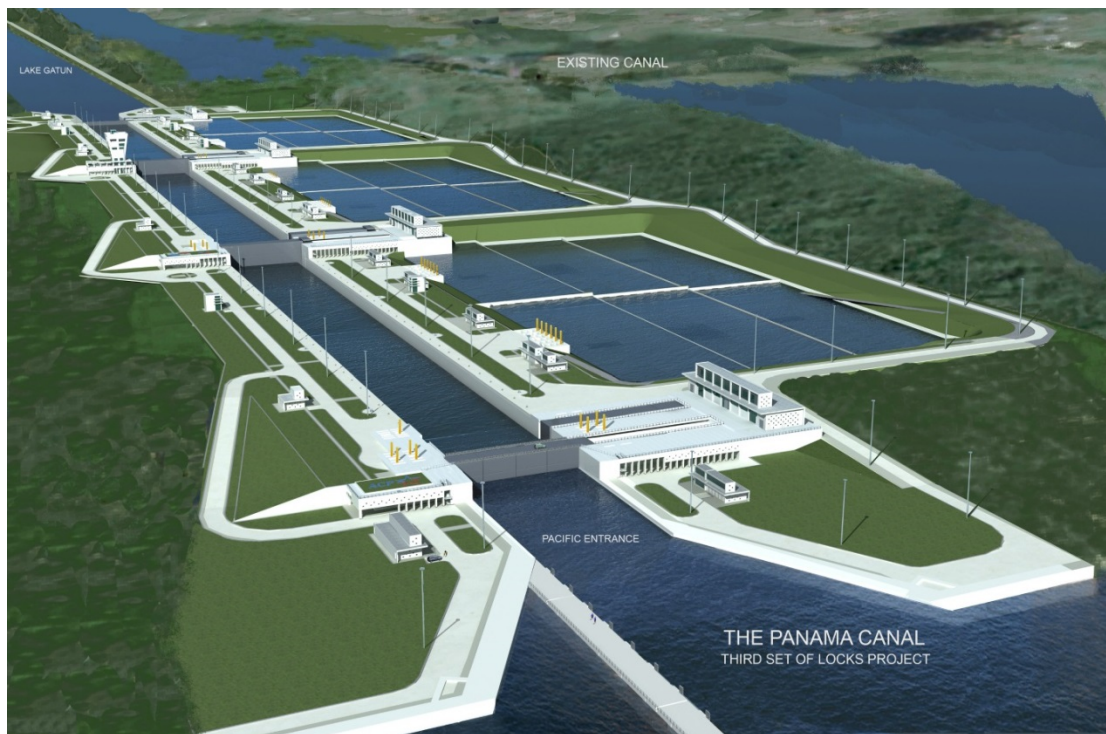
Εικόνα 7: Επέκταση της διώρυγας του Παναμά
