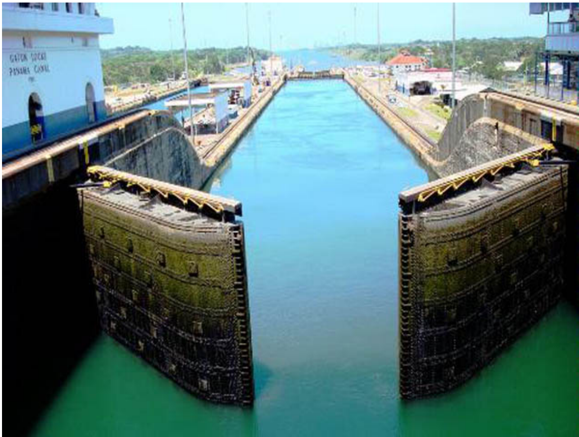
Εικόνα 10: Πύλες σε σχήμα “V”
