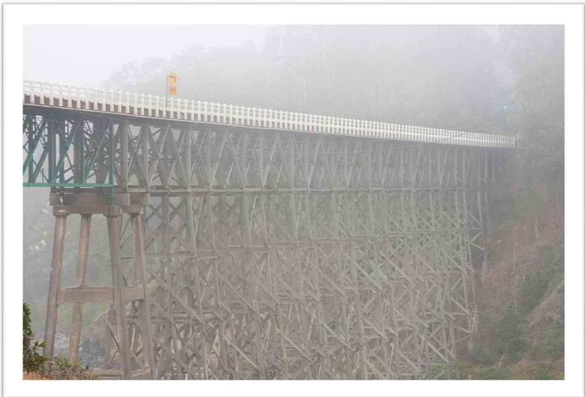
Εικόνα 4. Albion River Bridge -έτος κατ.: 1944, μήκος 300 μ., ύψος 40 μ., εμποτισμένη ξυλεία copper azole, και κεντρικά χάλυβας ως center truss - ΒΙΚΙΠΑΙΔΕΙΑ.
