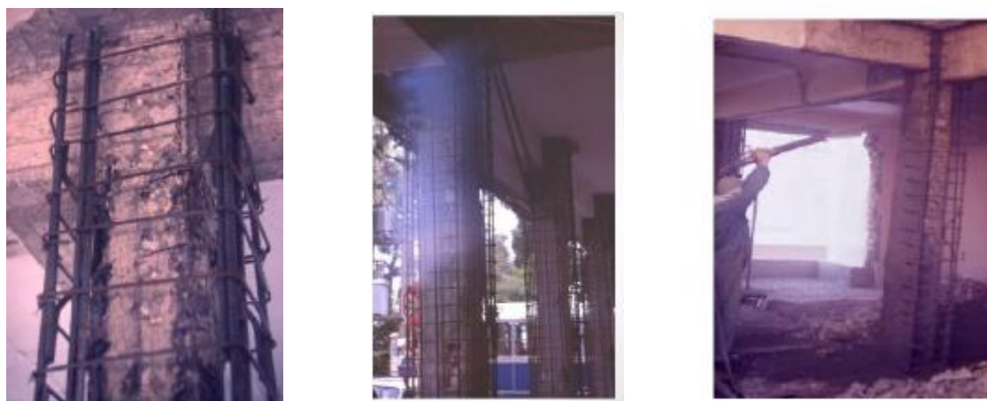
Εικόνες 56 : Ενίσχυση υποστυλώματος με μανδύα οπλισμένου σκυροδέματος
