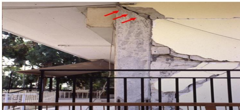
Εικόνα 9 : Διαγώνια ρηγάτωση εξωτερικού κόμβου
