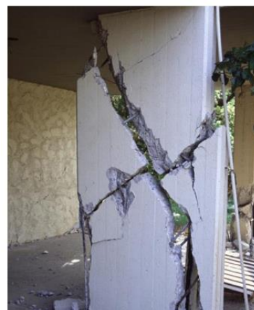
Εικόνα 11 : Διατμητική αστοχία τοιχώματος με μεγάλες παραμορφώσεις
