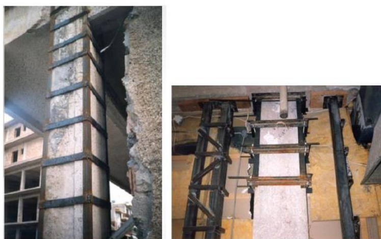
Εικόνα 59: Ενίσχυση υποστυλώματος με μεταλλικό κλωβό
