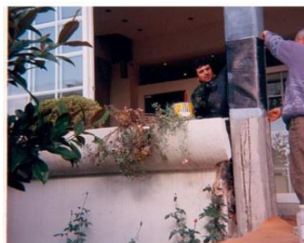
Εικόνα 52 : Περίσφιξη υποστυλώματος με χαλύβδινα ελάσματα
