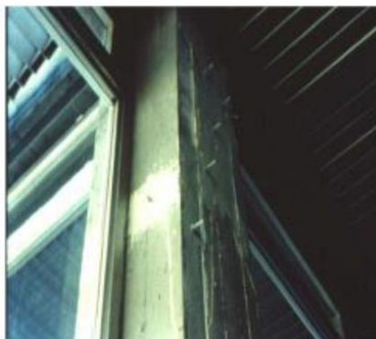
Εικόνα 50 : Επισκευη με ρητινενεσεις
