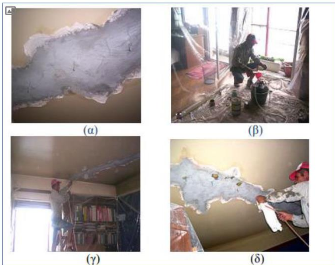
Εικόνα 47 α) Σφράγιση ρωγμής, (β) Τοποθέτηση ακροφυσίων, (γ) Είσοδος πεπιεσμένου αέρα, (δ) Διοχέτευση εποξειδικής ρητίνης
