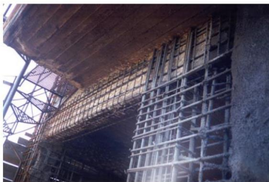
Εικόνα 86 : Ενίσχυση δοκού και υποστρώματος με κατασκευή μανδύα οπλισμένου σκυροδέματος
