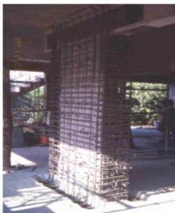
Εικόνα 70: Ενίσχυση τοιχώματος με μανδύα οπλισμένου σκυροδέματος (Δρίτσος 2014)
