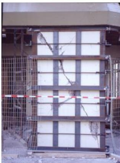
Εικόνα 71: Ενίσχυση τοιχώματος με μεταλλικό κλωβό
