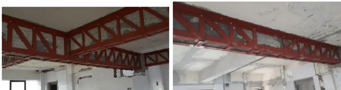
Εικόνα 81 : Ενίσχυση δοκού με μεταλλικές λάμες
