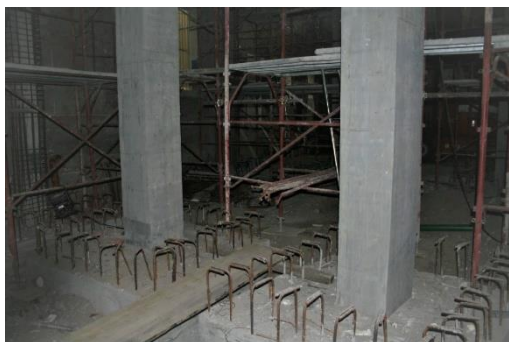
Εικόνα 49 : Σταδια ενισχυσης με μανδύας
