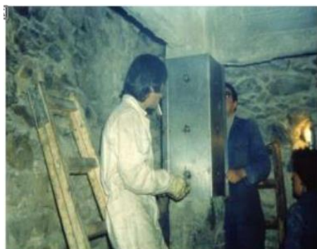
Εικόνα 52 : Περίσφιξη υποστυλώματος με χαλύβδινα ελάσματα
