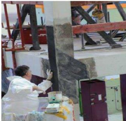
Εικόνα 66 : Ενίσχυση κόμβου με ινοπλισμένα πολυμερή (Δρίτσος 2014)
