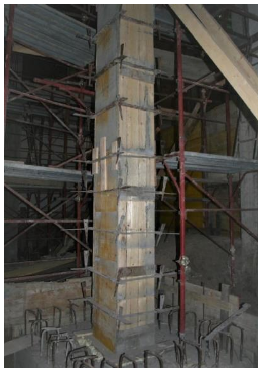
Εικόνα 49 : Σταδια ενισχυσης με μανδύας
