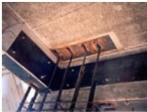
Εικόνα 82: Ενίσχυση δοκού με χαλύβδινα ελάσματα
