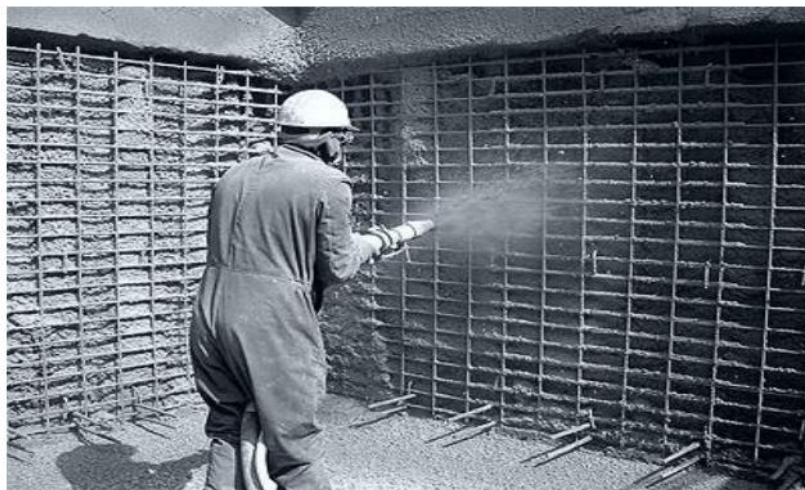
Εικόνα 47 : Εκτοξευόμενο σκυρόδεμα
