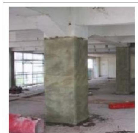
Εικόνα 55: Περίσφιξη υποστλώματος με μανδύα από ινοπλισμένα πολυμερή (FRP's)
