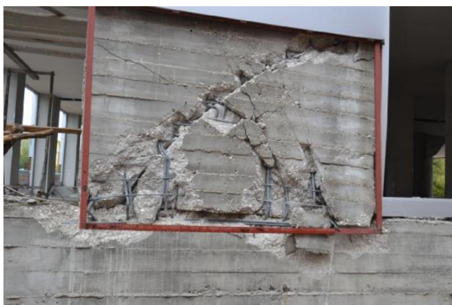
Εικόνα 11 : Διατμητική αστοχία τοιχώματος με μεγάλες παραμορφώσεις
