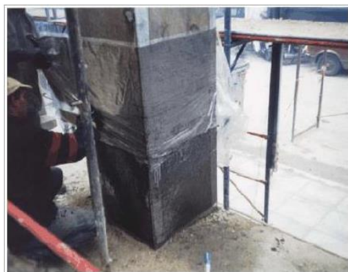
Εικόνα 55: Περίσφιξη υποστλώματος με μανδύα από ινοπλισμένα πολυμερή (FRP's)
