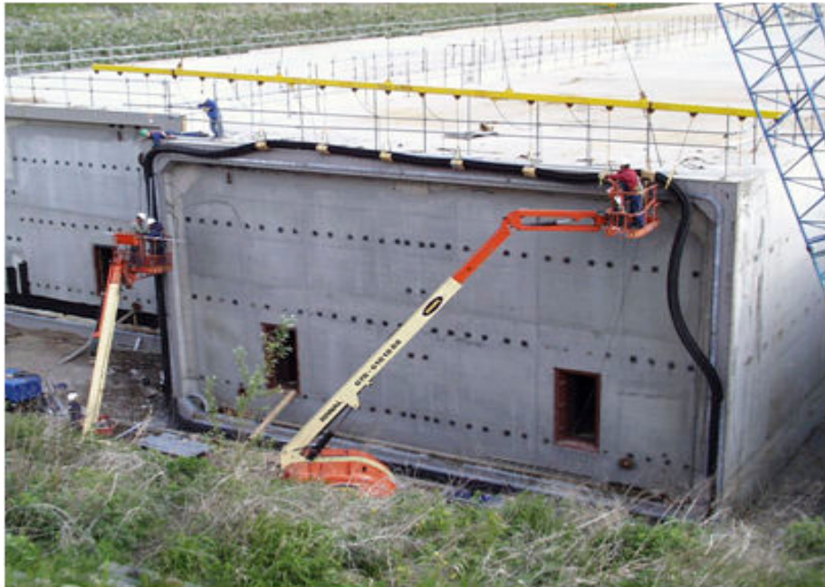
Σχήμα 3.7 Τοποθέτηση ελαστικών παρεμβυσμάτων στην άκρη ενός στοιχείου, by directindustry.com
