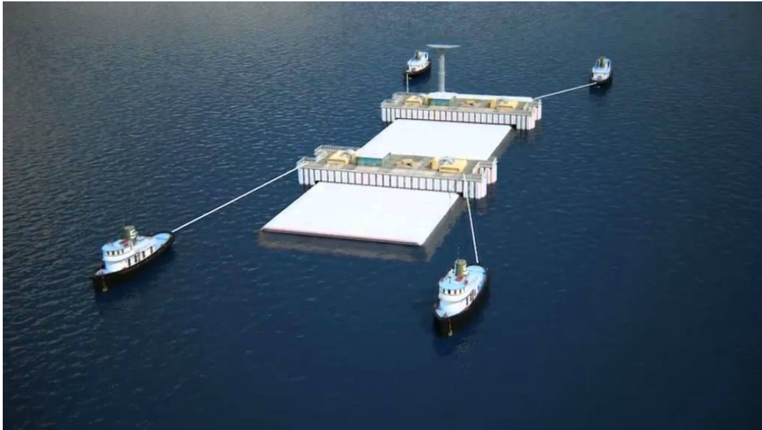
Σχήμα 2.12 Ρυμούλκηση των στοιχείων της σήραγγας, by railsystem.net
