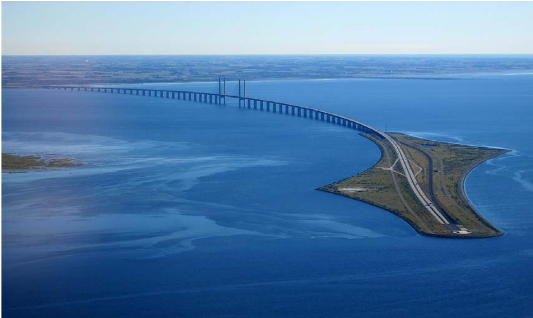
Σχήμα 5.1 Αεροφωτογραφία της γέφυρας του Øresund, by Wikipedia
