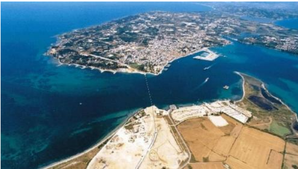
Σχήμα 5.7 Εναέρια φωτογραφία της θέσης της σήραγγας, by carandmotor.gr
