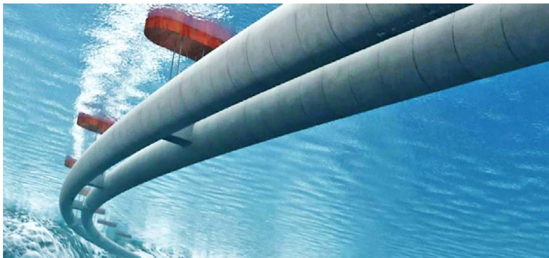
Σχήμα 1.18 Προσομοίωση πλωτών σηράγγων με πλωτήρες, by inhabitat.com
