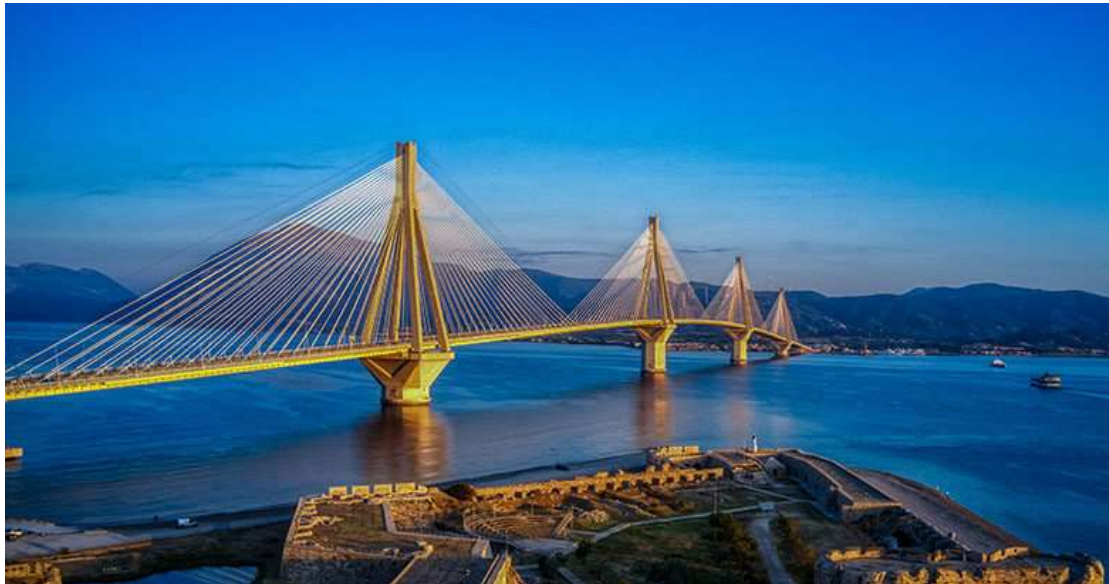
Εικόνα 3.1 Η γέφυρα Ρίου- Αντιρρίου
