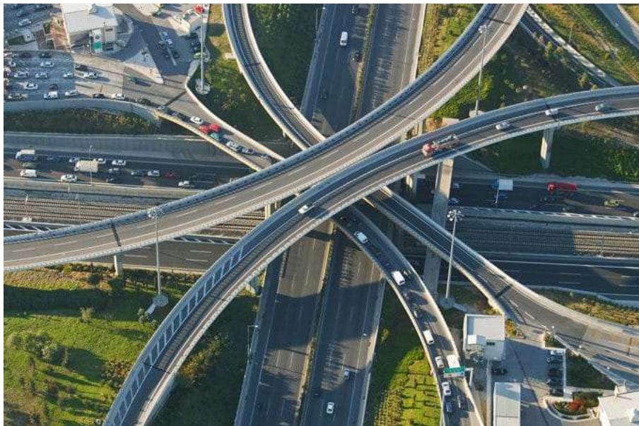
Εικόνα 3.2 Τμήμα της Αττικής Οδού
