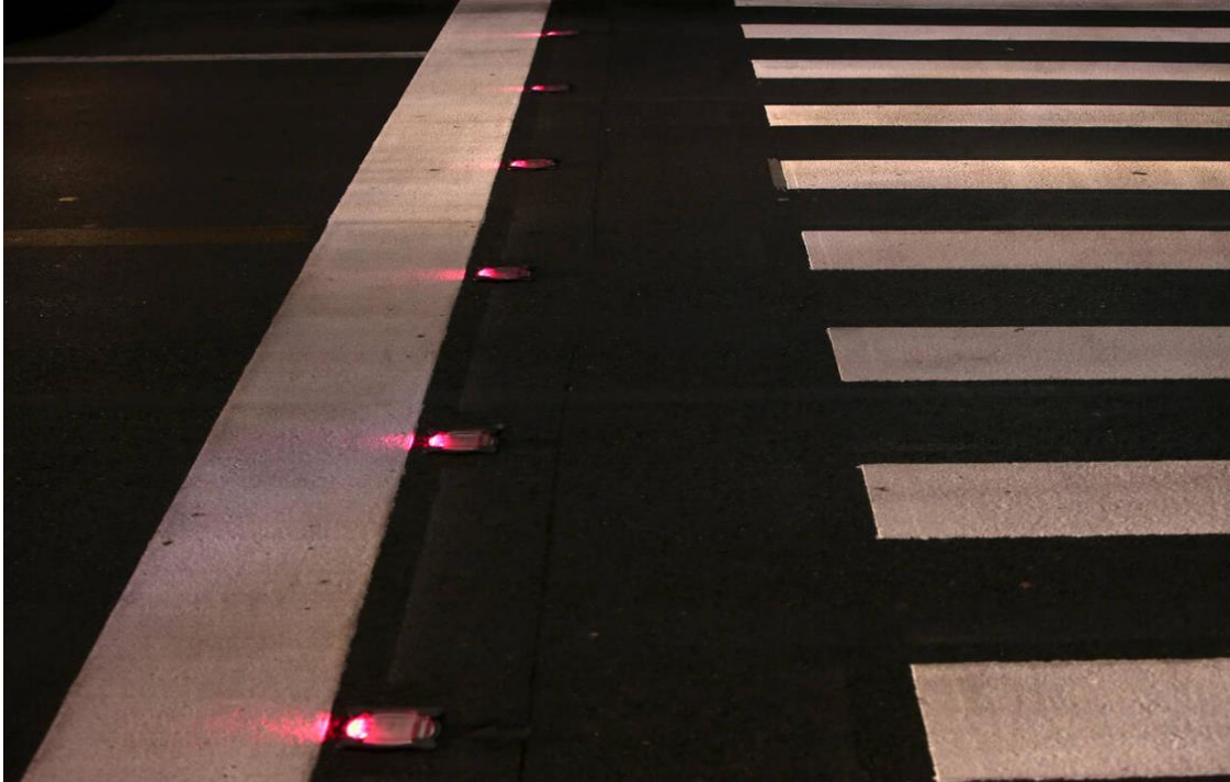
Εικόνα 2: Έξυπνη διάβαση πεζών στο Καλλιμάρμαρο
