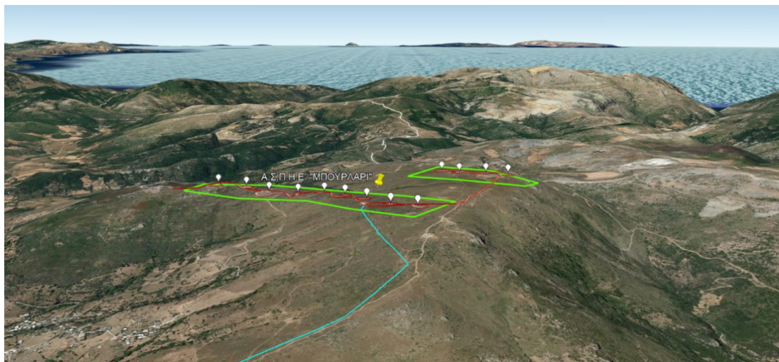
Εικόνα 7-4 Άποψη του χώρου εγκατάστασης του Α.Σ.Π.Η.Ε. Μπούρλαρι σε υπόβαθρο Google earth
