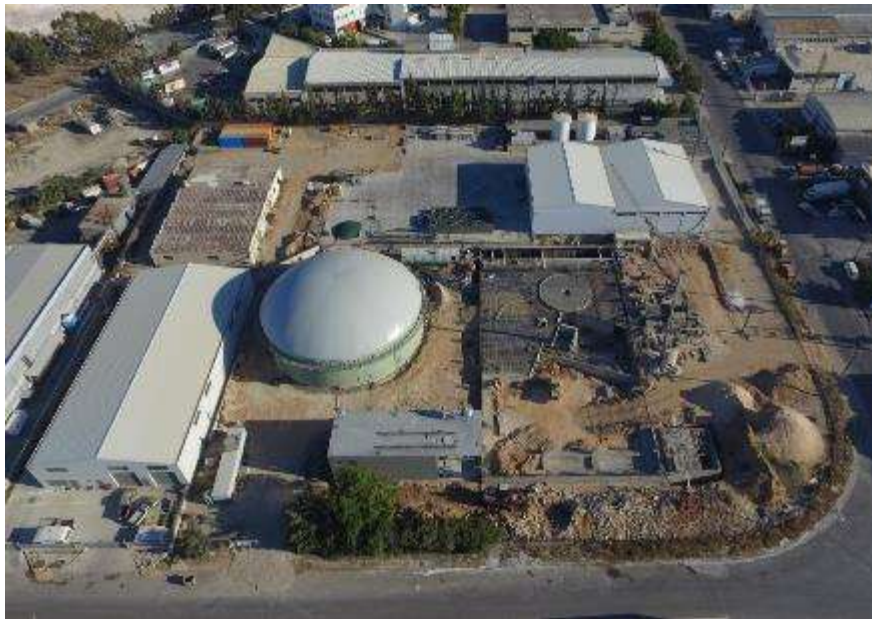
Εικόνα 3 Κατασκευή υπόγειας δεξαμενής ανάμειξης α υλών
