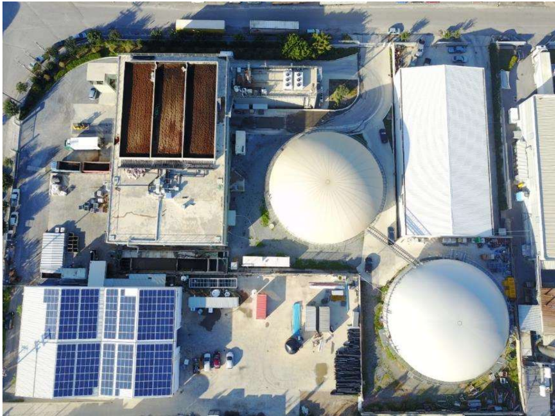
Εικόνα 5 Πανοραμική λήψη της μονάδας και των εγκαταστάσεων μετά την ολοκλήρωση κατασκευής του 2ου βιοαντιδραστήρα και επαύξηση της ισχύος σε 999KW
