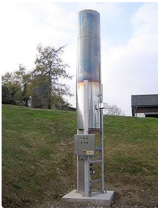
Σχήμα 37 Πυρός Καύσης Περίσσειας Βιοαερίου ( http://www.envima.gr )
