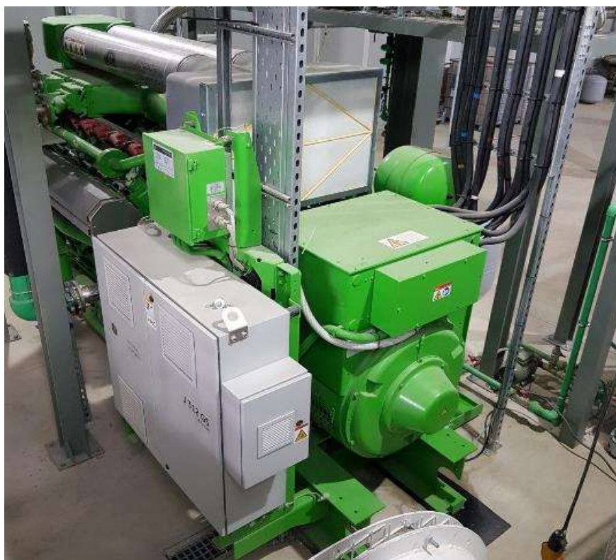
Σχήμα 65 Διαταξη ΣΗΘ
