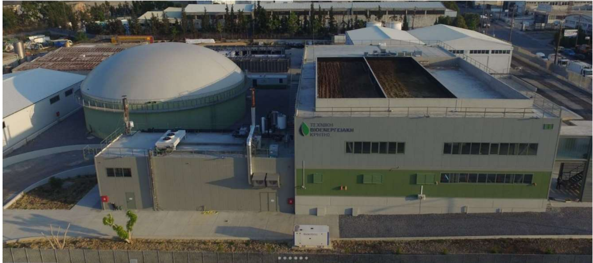
Εικόνα 4 Ολοκλήρωση εγκαταστάσεων βιοαερίου και λειτουργία μονάδας με 1 βιοαντιδραστήρα και δυναμικότητα ισχύος σταθμού στα 500Kw
