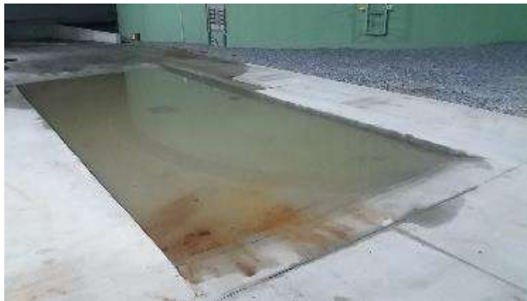
Εικόνα 7 Εγκατάσταση λεκάνης απολύμανσης τροχών φορηγών μεταφοράς α υλών
