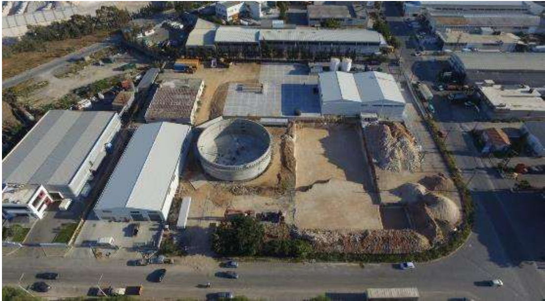
Εικόνα 2 Κατασκευή 1ου βιοαντιδραστήρα
