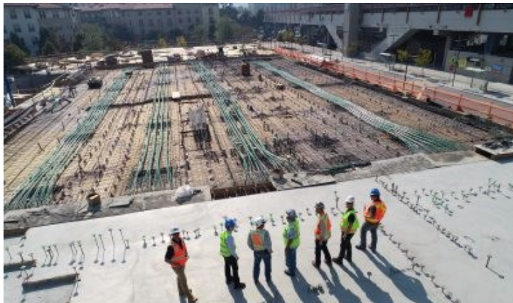
Εικόνα 8. Ο κλάδος των κατασκευών
