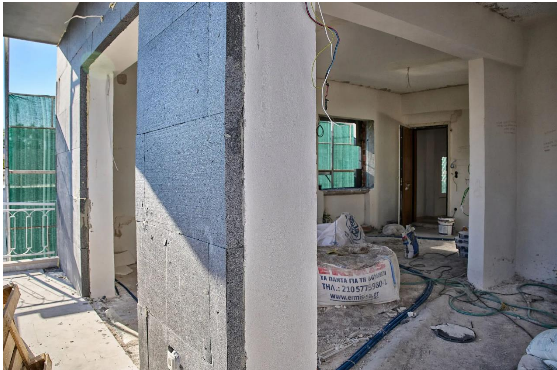
Εικόνα 12 Μόνωση εξωτερικού τοίχου
