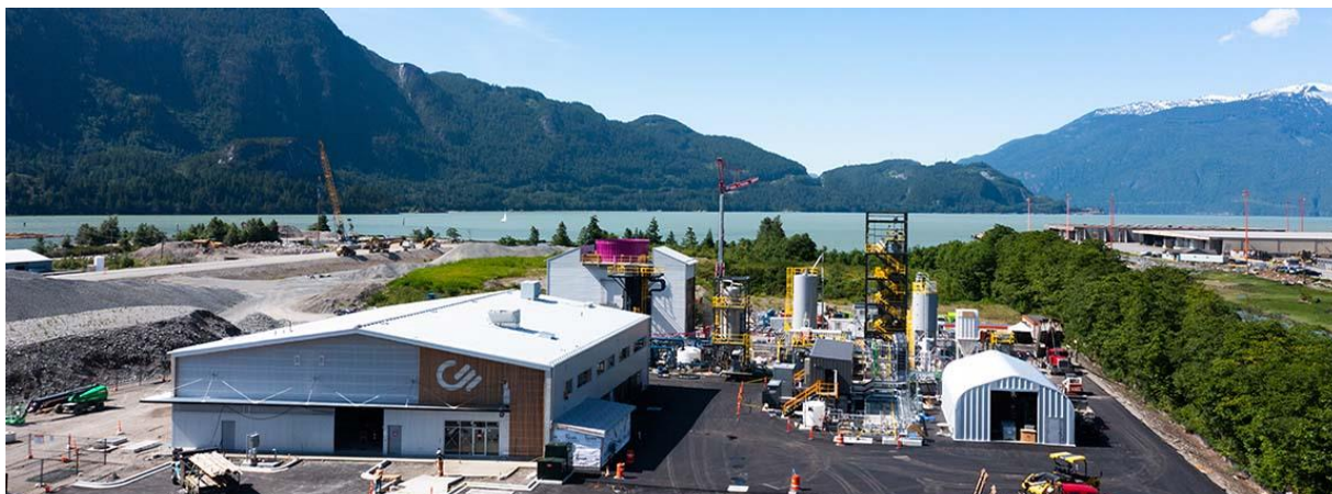
Σχήμα 16: Κέντρο καινοτομίας της Carbon Engineering στο Squamish της Βρετανικής Κολομβίας, (Griffin, 2021)
