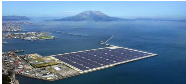
Εικόνα 11: Παράκτιο φωτοβολταϊκό πάρκο (Θεοδοσιάδης, 2020)
