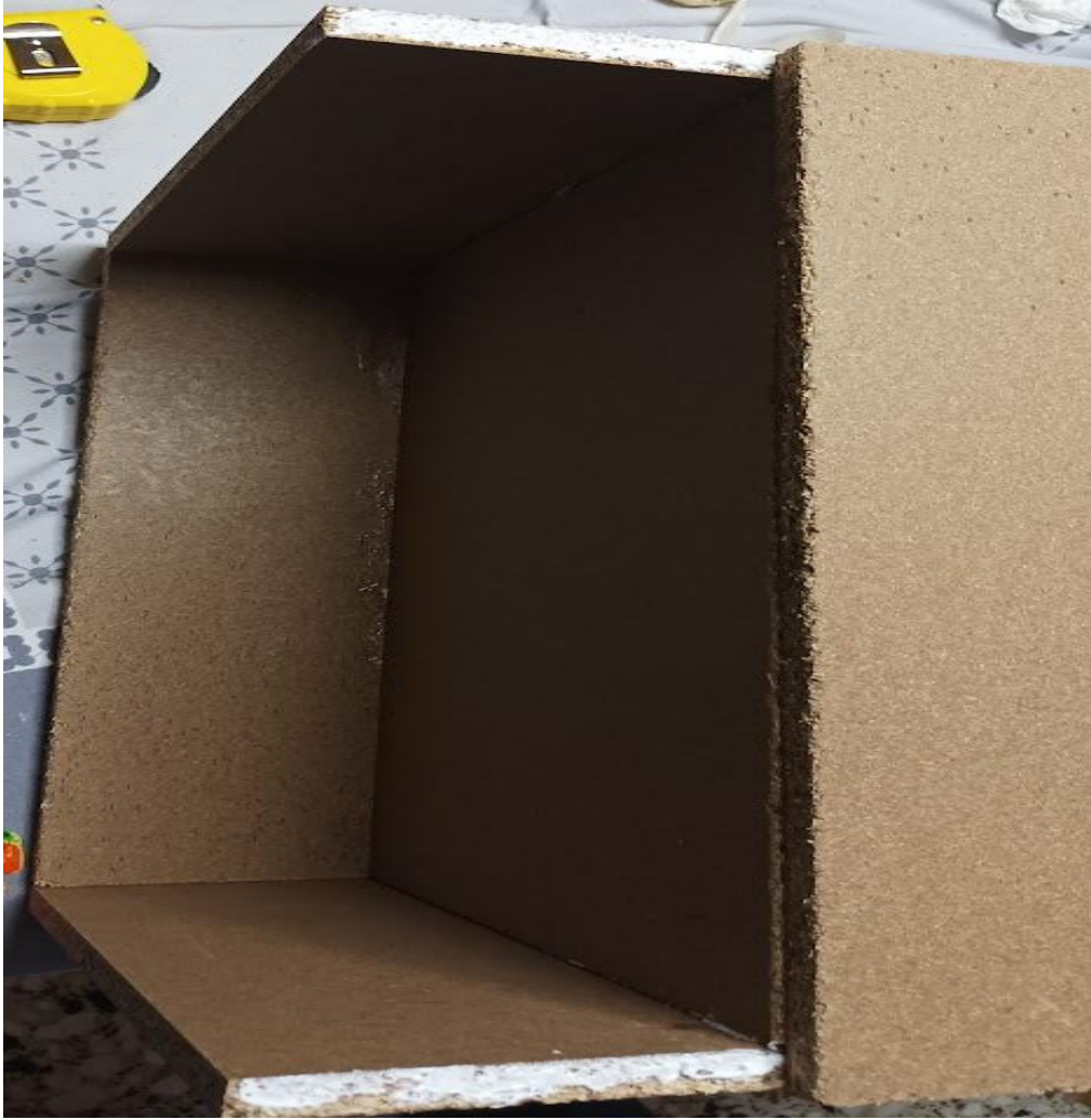
Εικόνα 17: Εφαρμογή ξυλόκολλας στο σημείο που θα τοποθετηθεί το κάλυμμα πάνω από την πόρτα.
