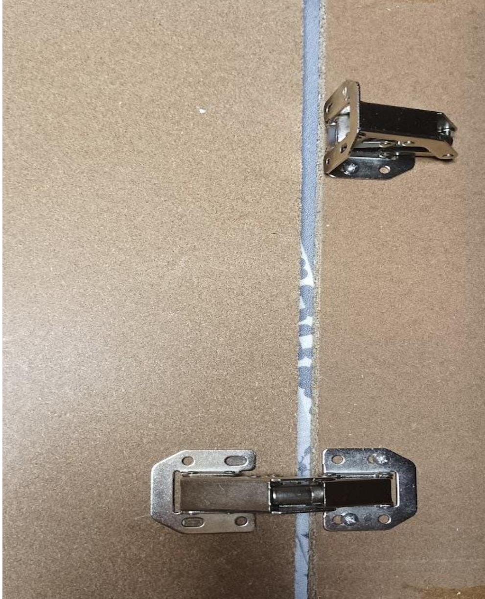
Εικόνα 19: Τοποθέτηση μεντεσέδων.
