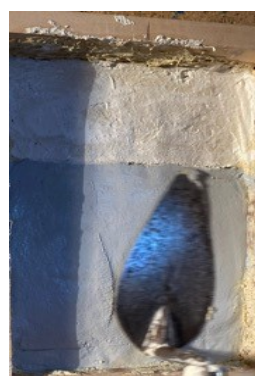
Εικόνα 5.(ζ.) Με ένα μικρό μυστρί διασπάται το κρυσταλλικό ανθρακικό ασβέστιο που έχει σχηματιστεί, διεξάγεται το λεγόμενο «στίλβωμα». Πηγή: Προσωπικό αρχείο.
