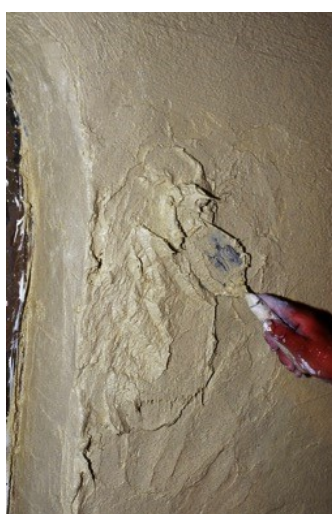
Εικόνα 3.3.5.(α.) Εναπόθεση του 1 ου στρώματος κονιάματος με την χρήση μυστριού. Πηγή: Προσωπικό αρχείο.
