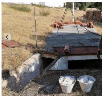
Εικόνα 4.1.(α.) Εξωτερική όψη της κατασκευής του λάκκου για την παλαίωση του ασβέστη σε εξωτερικό χώρο της Ιεράς Μονής Αγίου Εφραίμ Νέας Μάκρης Αττικής. Πηγή: Προσωπικό αρχείο.
