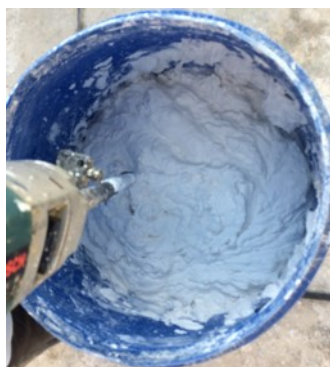
Εικόνα 4.2.(κζ.) Στιγμιότυπο από την ανάδευση 9 μερών ασβέστη και 1 μέρους κοσκινισμένης μαρμαρόσκονης για την παρασκευή του τελικού στρώματος κονιάματος με την χρήση συσκευής ηλεκτρικού αναδευτήρα. Πηγή: Προσωπικό αρχείο.
