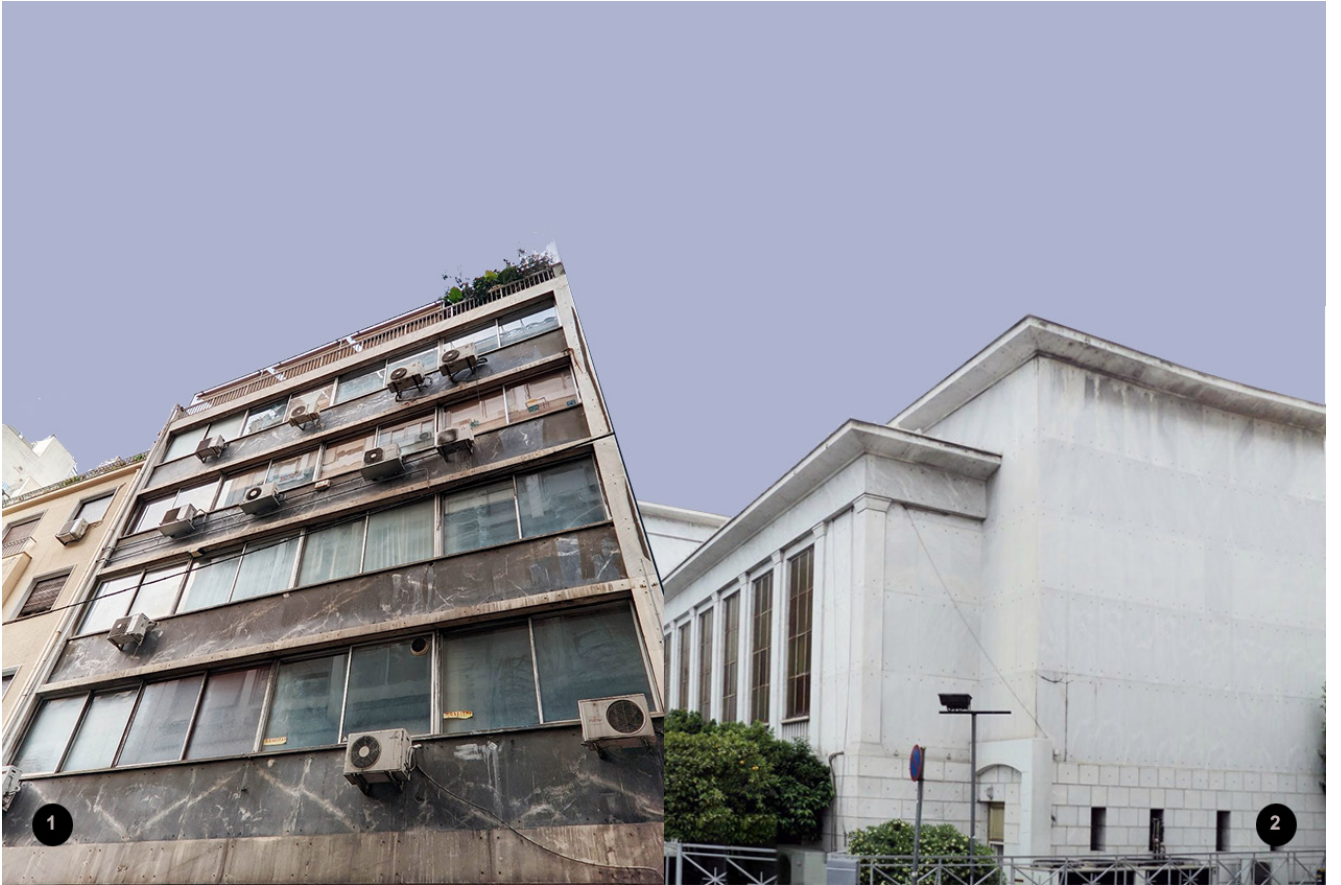
Εικόνα 12 Πρώτο & δεύτερο κτίριο προβολής video.
