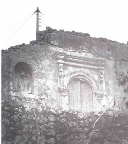
Εικ.4.1 Ο Ναός της Ζωοδόχου Πηγής (Μετασεισμικά) (Φωτ. Λ. Σιμάτος) Οι ναοί του Αργοστολίου στα χρόνια της Ένωσης (1864) – Σταματούλα Ζαπάντη, Λάμπρος Σιμάτος.
