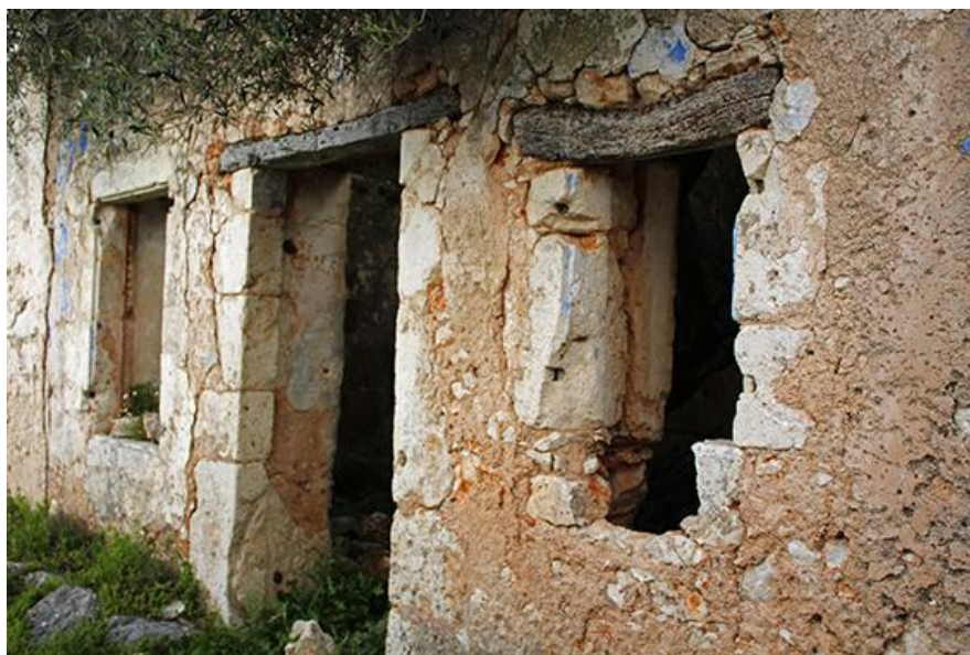
Εικ.3.2.1 Το καφενείο του χωριού με τα ξύλα τοποθετημένα στην πόρτα και στα παράθυρα.
