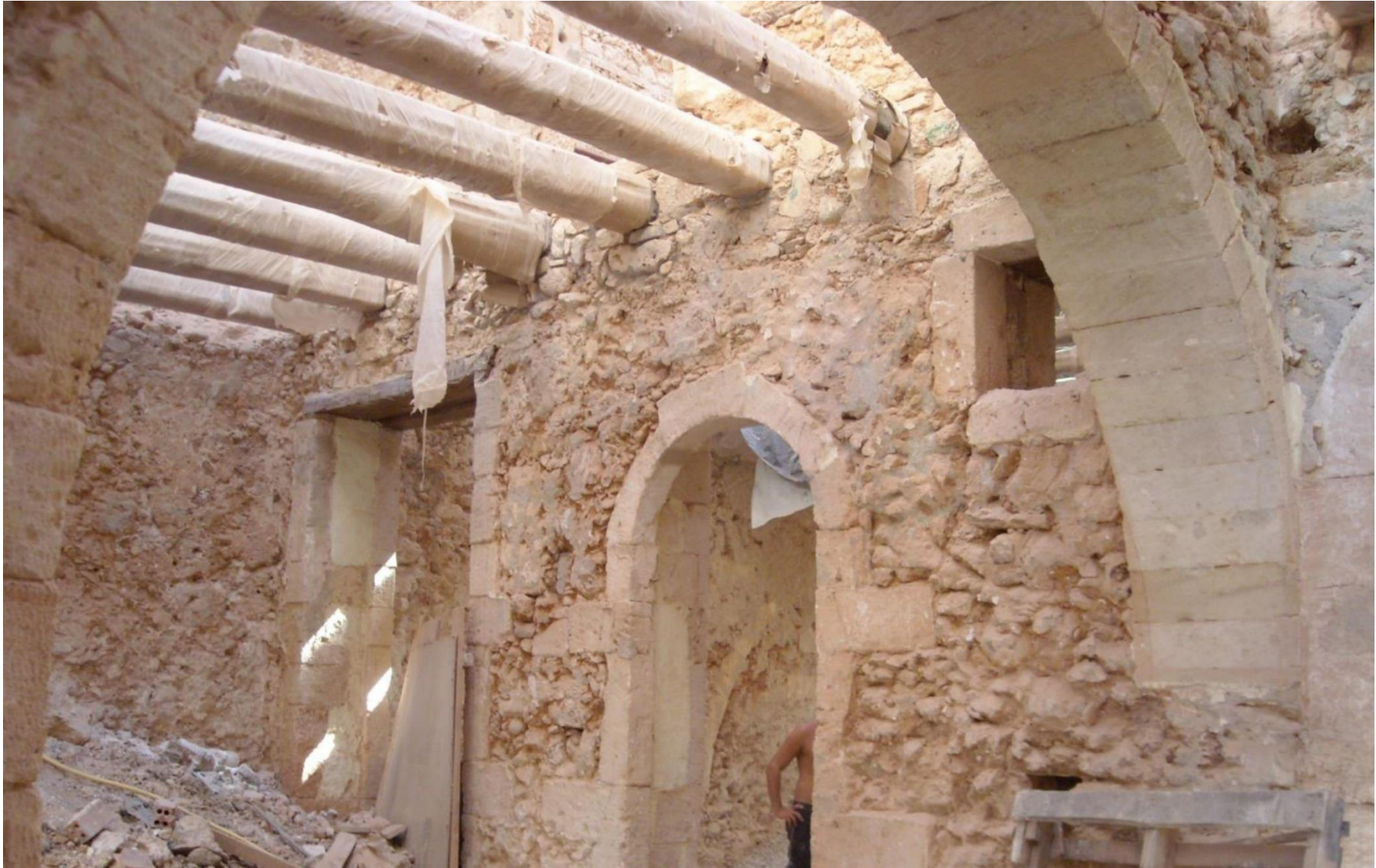
Εικόνα 136 Εμφανή δοκάρια σε κτήριο
