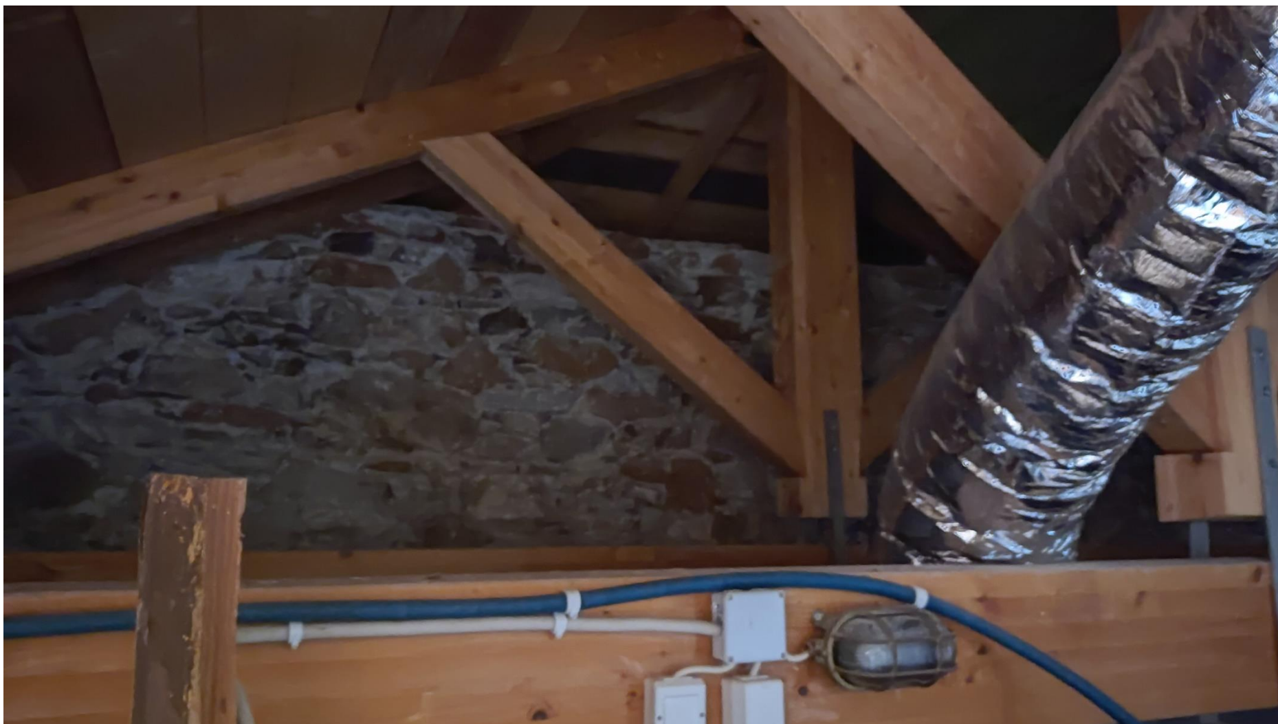
Εικόνα 153 Φωτογραφία από τον φορέα της στέγης, προβάλλοντας τον τρόπο σύνδεσης της με το κτήριο και μεταξύ της σε συνδυασμό με την χρήση μεταλλικών στοιχείων
