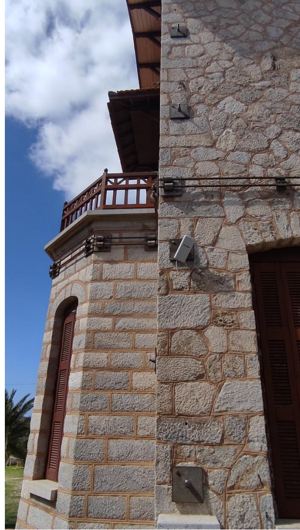
Εικόνα 171 Ο συνδυασμός τοποθέτησης ντίζων και ελκυστήρων εξωτερικά του κτηρίου
