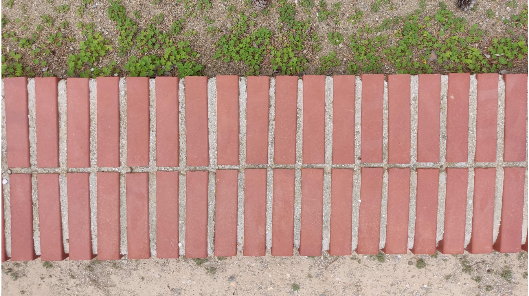
Εικόνα 164 Χτίσιμο πεζουλιού με τούβλα
