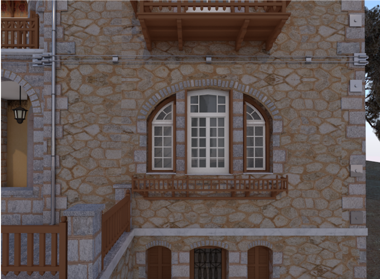
Εικόνα 197 Παράθυρο αποτελούμενο από τρία μέρη με τοξοειδής κατάληξη (λεπτομέρεια)
