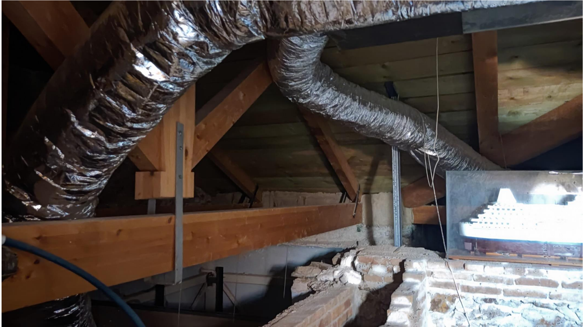
Εικόνα 155 Φωτογραφία από τον φορέα της στέγης, προβάλλοντας τον τρόπο σύνδεσης της με το κτήριο και μεταξύ της σε συνδυασμό με την χρήση μεταλλικών στοιχείων
