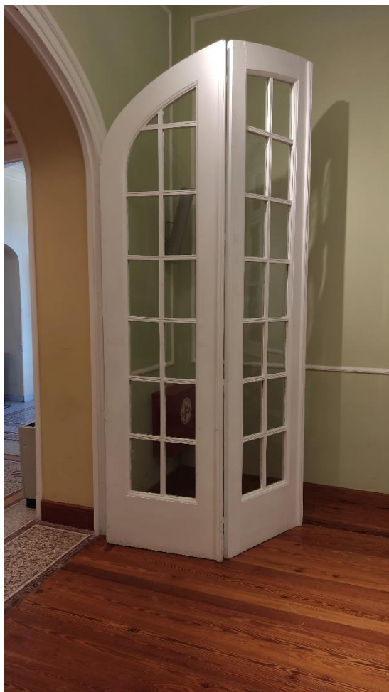
Εικόνα 125 Μεσόπορτα που χώριζε το ανδρικό κεντρικό σαλόνι με την τραπεζαρία, χρήση καϊτιών, σπάσιμό σε δύο φύλλα
