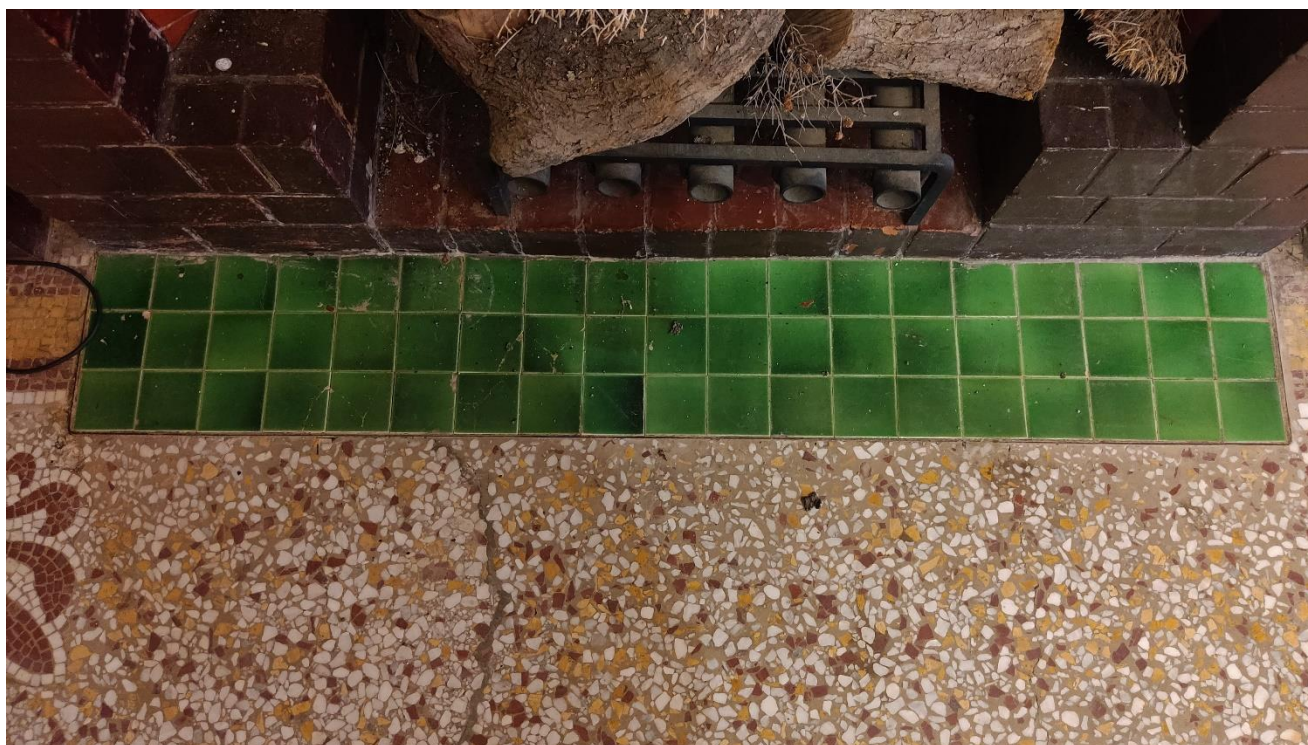
Εικόνα 115 Λεπτομέρεια στο ανδρικό τζάκι, το πλακάκι που είχε τοποθετηθεί με στόχο να πέφτουν οι στάχτες
