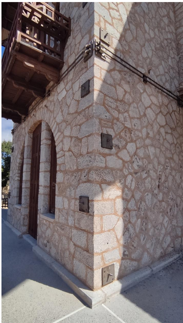
Εικόνα 99 Ημιλαξευμένοι και ορθογώνιοι ασβεστόλιθοι
