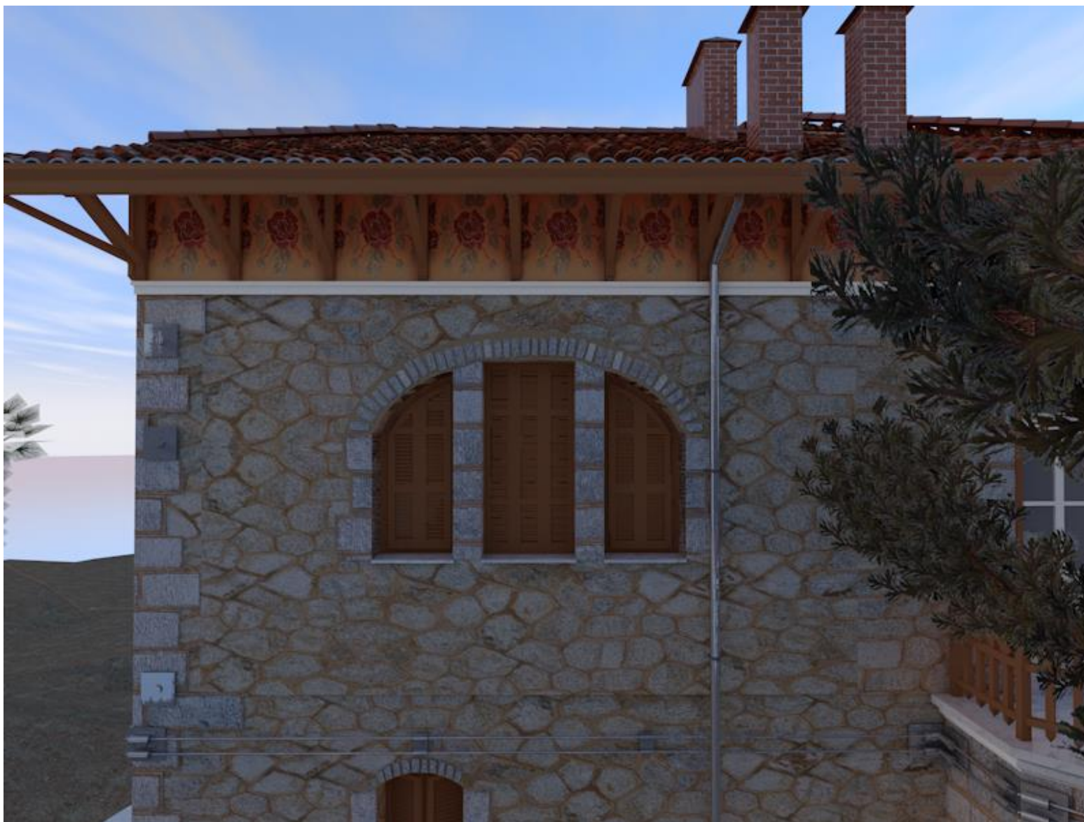
Εικόνα 207 Απεικόνιση τριαντάφυλλων, τοξωτού κλειστού παραθύρου γαλλικών παντζουριών, υδρορροή και ανοξείδωτων ελκυστήρων
