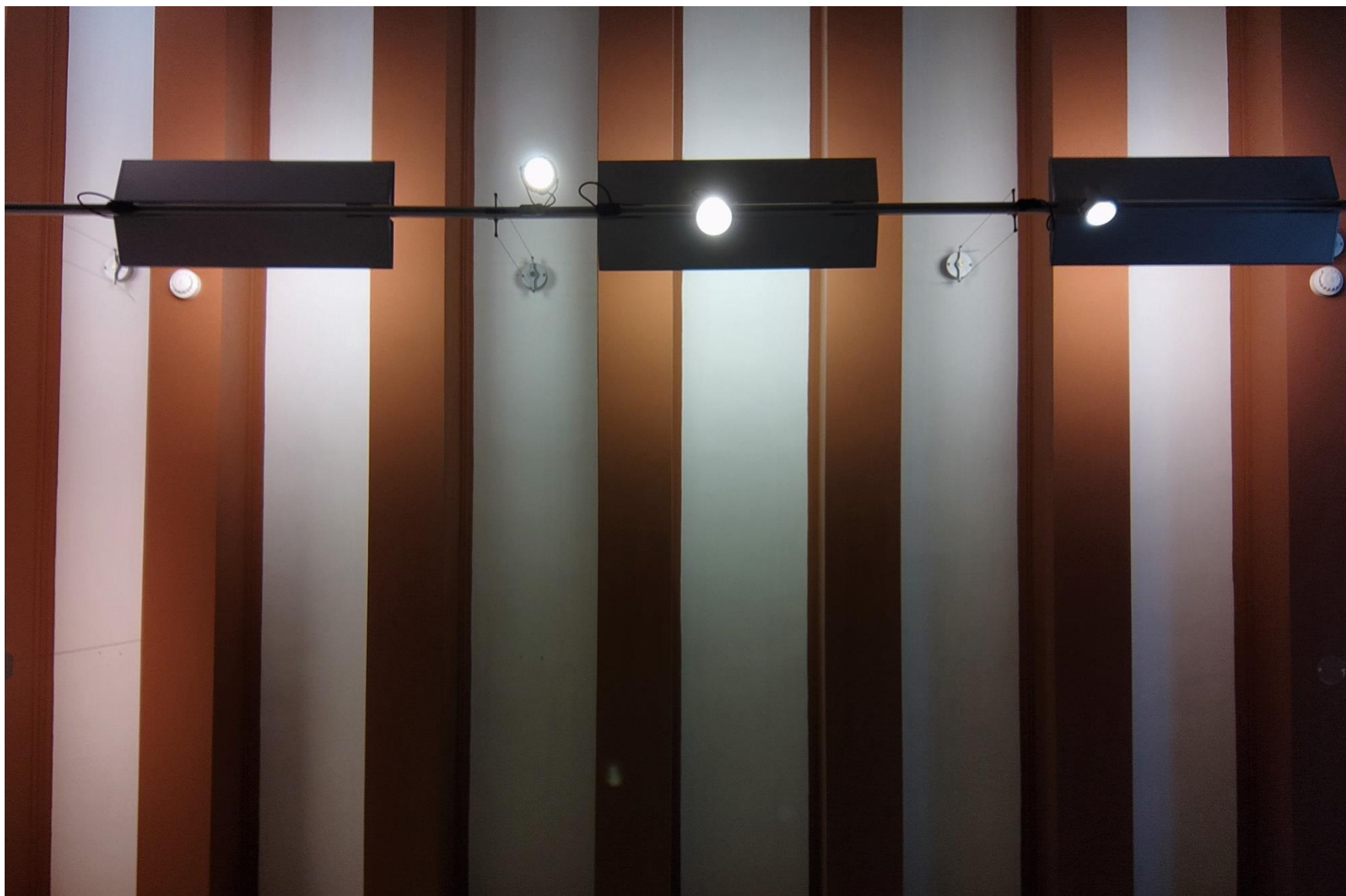
Εικόνα 121 Οροφή - ξύλινα δοκάρια ανδρικού σαλονιού
