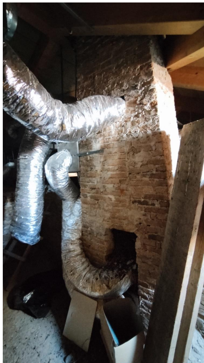
Εικόνα 174 Φωτογραφίες από το εσωτερικό της στέγης, παρατηρούνται οι αεραγωγοί καθώς και το παράθυρο μερικής πρόσβασης στα κεραμίδια
