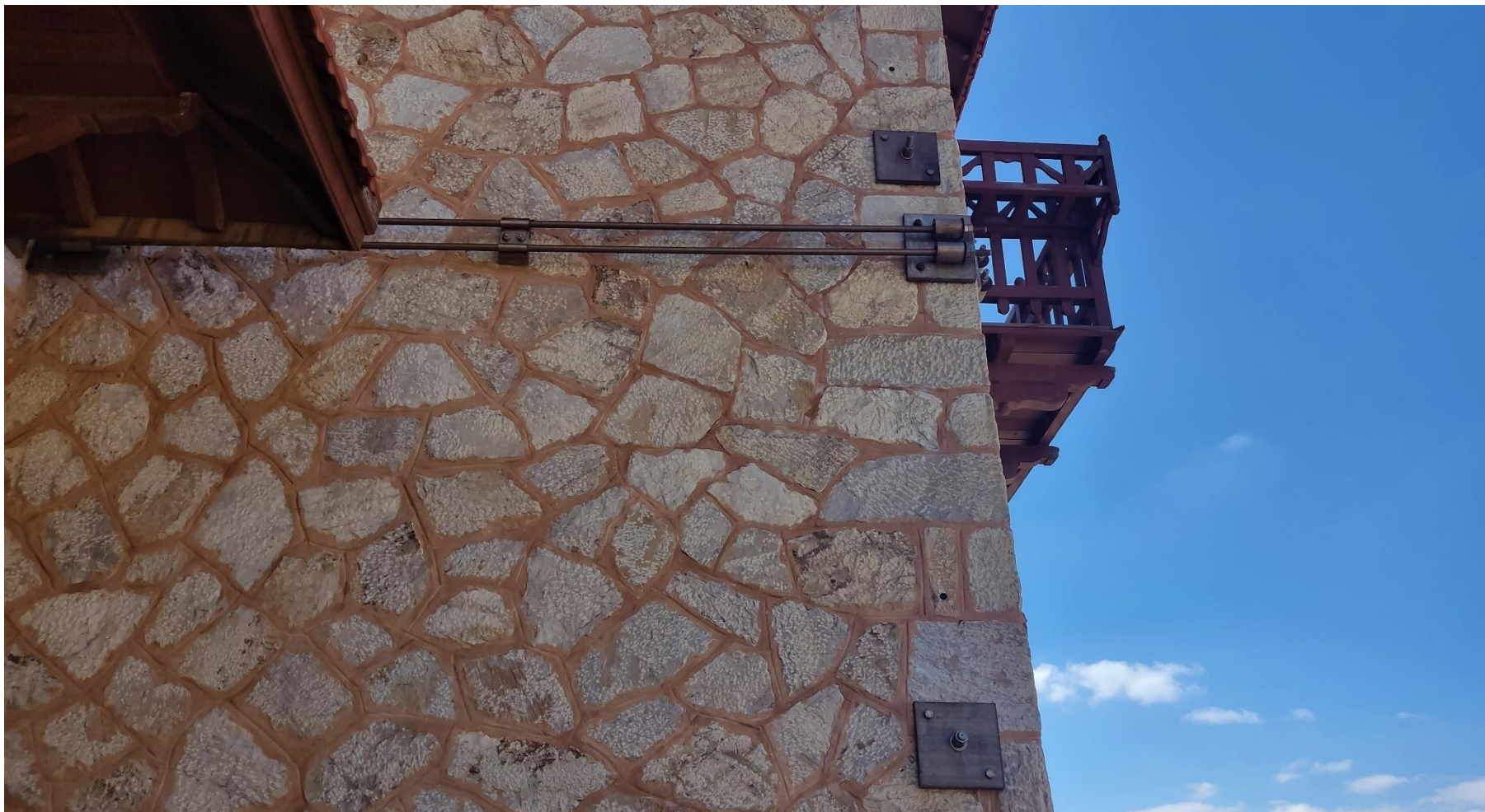
Εικόνα 102 Ανοξείδωτοι ελκυστήρες και ντίζες για την συγκράτηση των λιθοδομών
