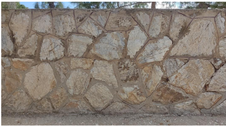
Εικόνα 65 Εξωτερική μεριά του λιθόκτιστου τοίχου
