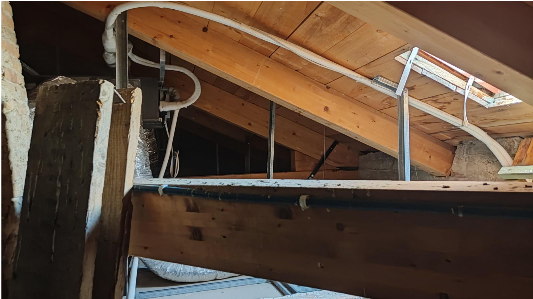
Εικόνα 154 Φωτογραφία από τον φορέα της στέγης, προβάλλοντας τον τρόπο σύνδεσης της με το κτήριο και μεταξύ της σε συνδυασμό με την χρήση μεταλλικών στοιχείων
