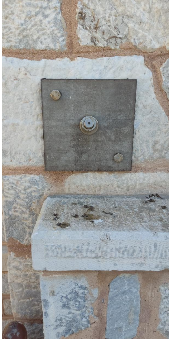
Εικόνα 171 Ο συνδυασμός τοποθέτησης ντίζων και ελκυστήρων εξωτερικά του κτηρίου
