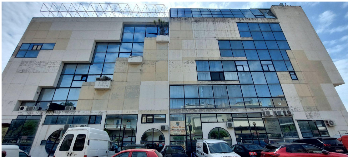
Εικόνα 12: Φωτογραφικό υλικό υφιστάμενης κατάστασης, Όψη επί της οδού Αμοργού.
