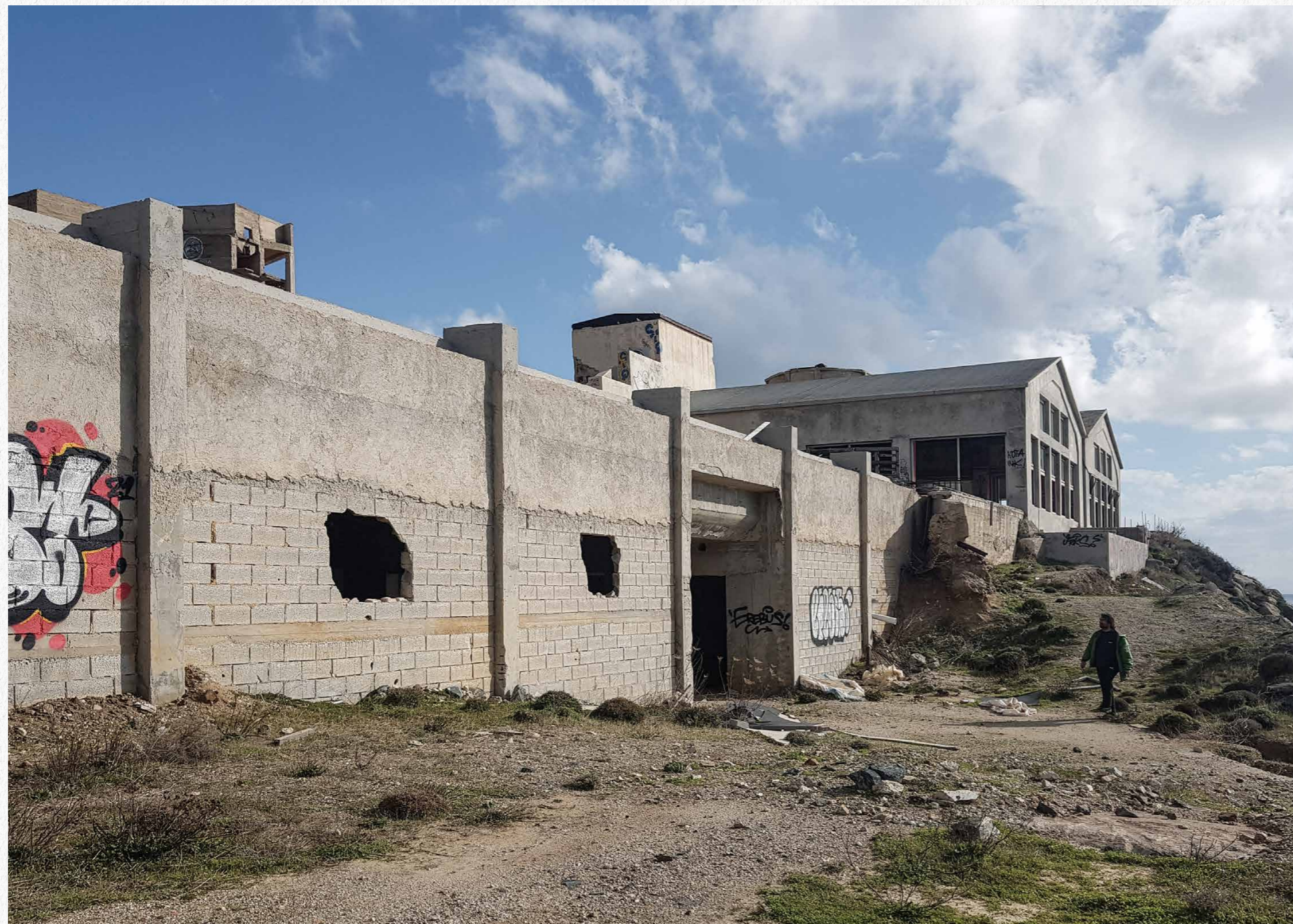
4.18 | Εξωτερικός Χώρος, Υπόγειο. Η κλίμακα του κτιρίου.
