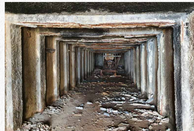
4.21 | Εξωτερικός Χώρος, το τούνελ της χοάνης όπου έσπραχναν το μεταλλευμα ώστε να μεταφερθεί με ταινία στην σκάλα φόρτωσης
