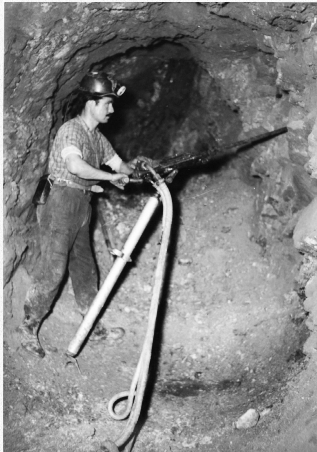
3.22 | Διάνοξη στοάς με αερόσφουρα. Αρχείο ΜΥΚΟΜΠΑΡ, 1958
