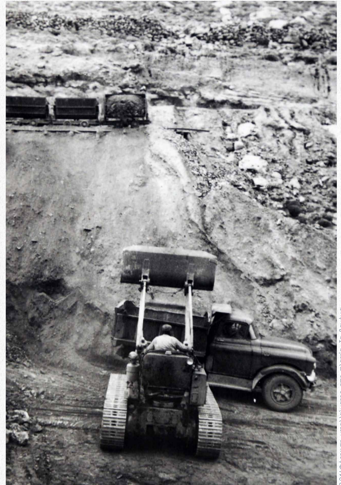
3.24 | Φόρτωση μεταλλεύματος από πλατεία. Τα βαγόνια αδειάζουν το μέταλλευμα με ανατροπή. Αρχείο ΜΥΚΟΜΠΑΡ
