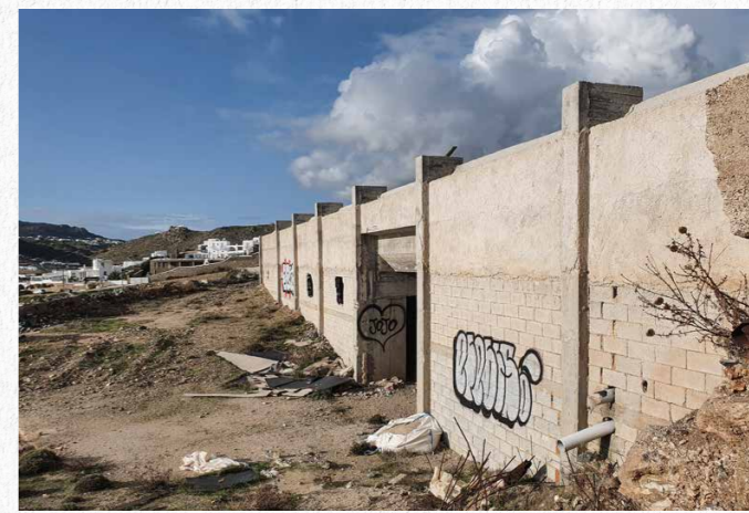
4.20 | Εξωτερικός Χώρος, Υπόγειο
