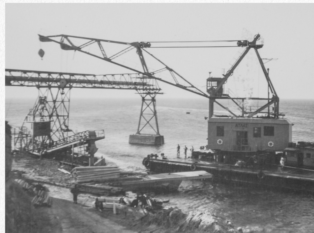
3.9 | Κατασκευή Σκάλας_ Αρχείο Martin, Ιούνιος 1956
