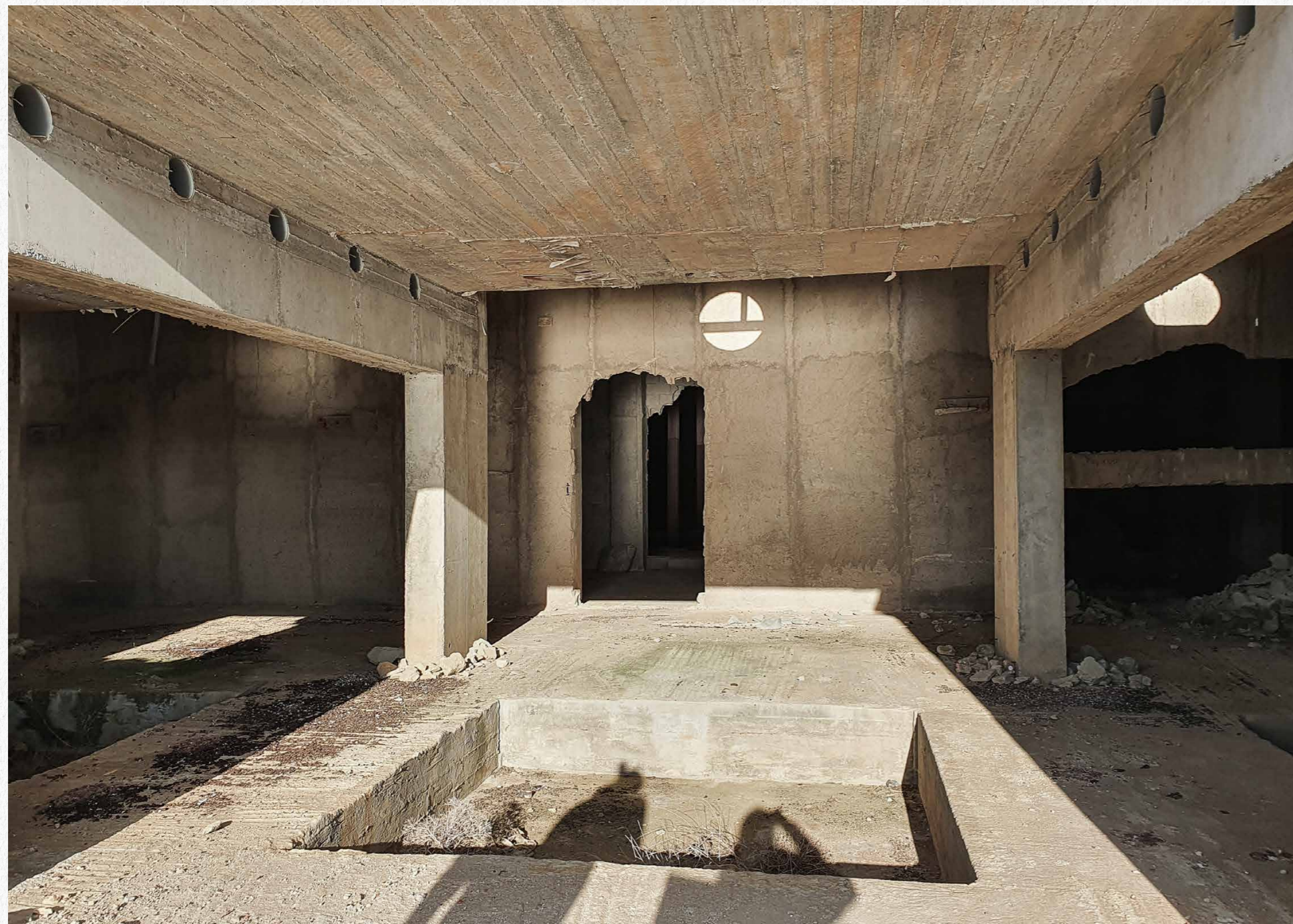
4.47 | Είσοδος από το άνοιγμα στο ύψος του Υπόγειου. Δεν βρέθηκε κάποια πληροφορία για τις εσοχές στο δάπεδο.
