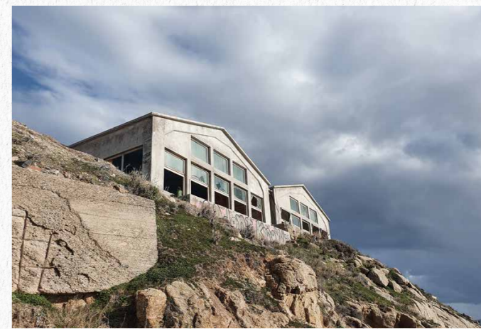
4.19 | Εξωτερικός Χώρος, Οπτική του κτιρίου από το σημείο εισόδου του τούνελ της χοάνης.
