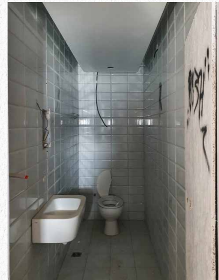
8 4.34 | Εσωτερικός Χώρος, Ισόγειο. WC που κατασκευάστηκαν μεταγενέστερα.
