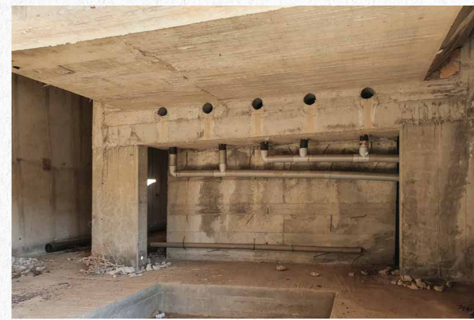
4.49 | Εσωτερικός Χώρος, Υπόγειο 2. Μοιάζει μεταγενέστερα να είχε ξεκινήσει η κατασκευή πλαισίου ακριβώς από πάνω στο ισόγειο
