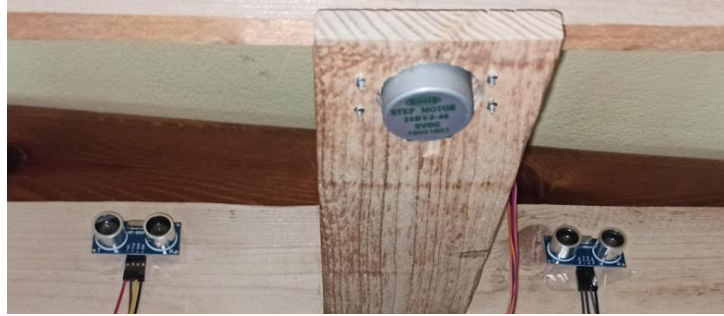
Εικόνα 2-5 : Τοποθέτηση αισθητήρων απόστασης
