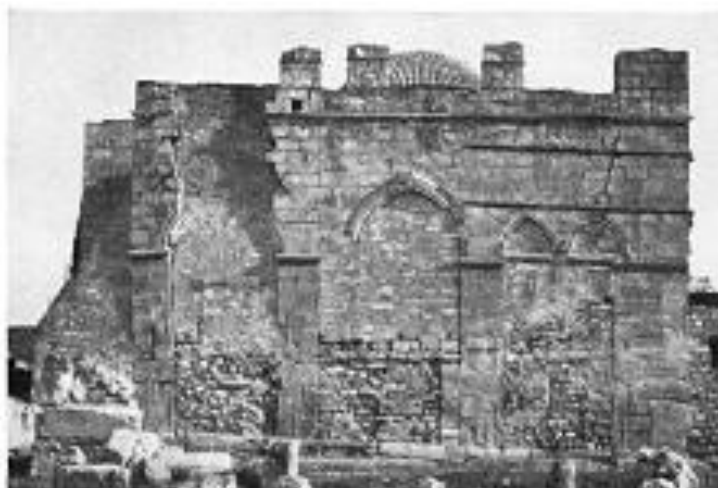
Εικόνα 13. Η δυτική όψη του εξωνάρθηκα πριν από την αναστήλωσή του από τον Στίκα Ε. και τον Μπούρα Χ. στην δεκαετία του 1950.
