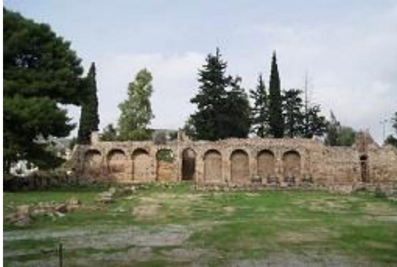
Εικόνα 28. Το δυτικό τμήμα του βόρειου τείχους της Μονής Δαφνίου (Εφορεία Αρχαιοτήτων Δυτικής Αττικής, https://www.efada.gr/ )
