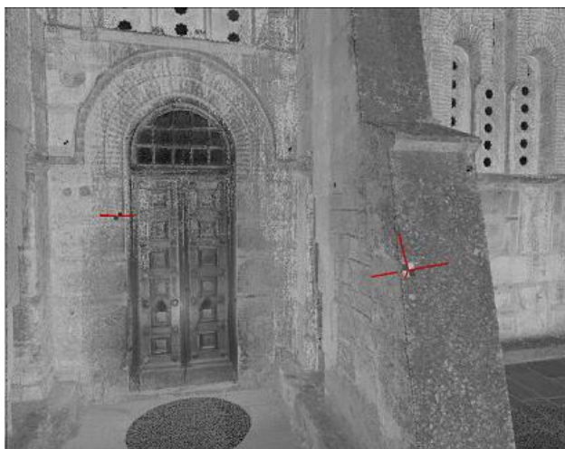
Εικόνα 107. Αναγνώριση στόχων στην βόρεια όψη της Μονής.
