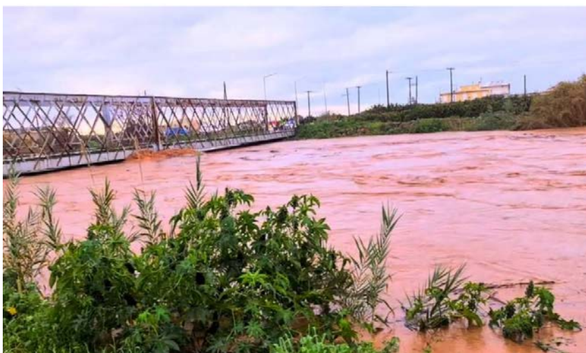
Εικόνα 3: Η γέφυρα του Ευρώτα εν ώρα πλημμύρας.
