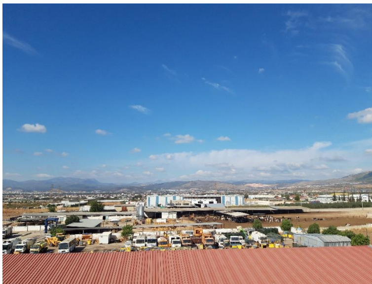
Εικόνα 5.3: Όψη από το Εργοτάξιο Ασπροπύργου 1/3
