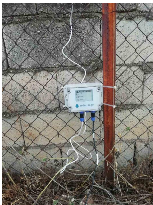
Εικόνα 5.15: Εγκατάσταση έξυπνου μετρητή 1/3
