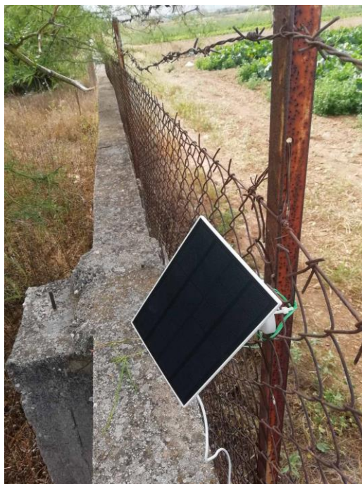
Εικόνα 5.16: Εγκατάσταση έξυπνου μετρητή 2/3
