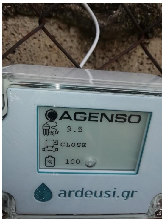
Εικόνα 5.17: Εγκατάσταση έξυπνου μετρητή 3/3
