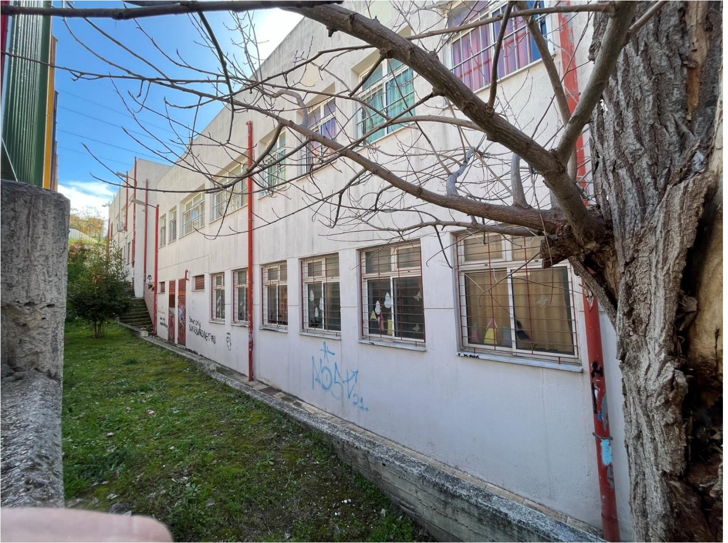
Εικόνα 5: Βόρεια Όψη Κτιρίου 2 (K2)
