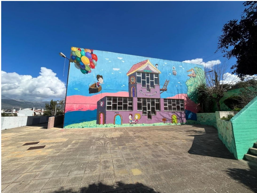
Εικόνα 7: Νότια Όψη Κτιρίου 3 (Κ3)
