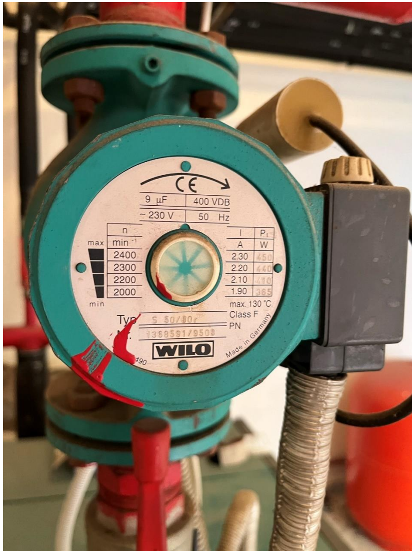
Εικόνα 33: Κυκλοφορητής Λέβητα
