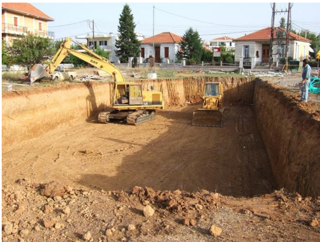
Εικόνα 1: Ενδεικτική φωτογραφία εκσκαφής θεμελίωσης (Ανδριανόπουλος, n.d.)
