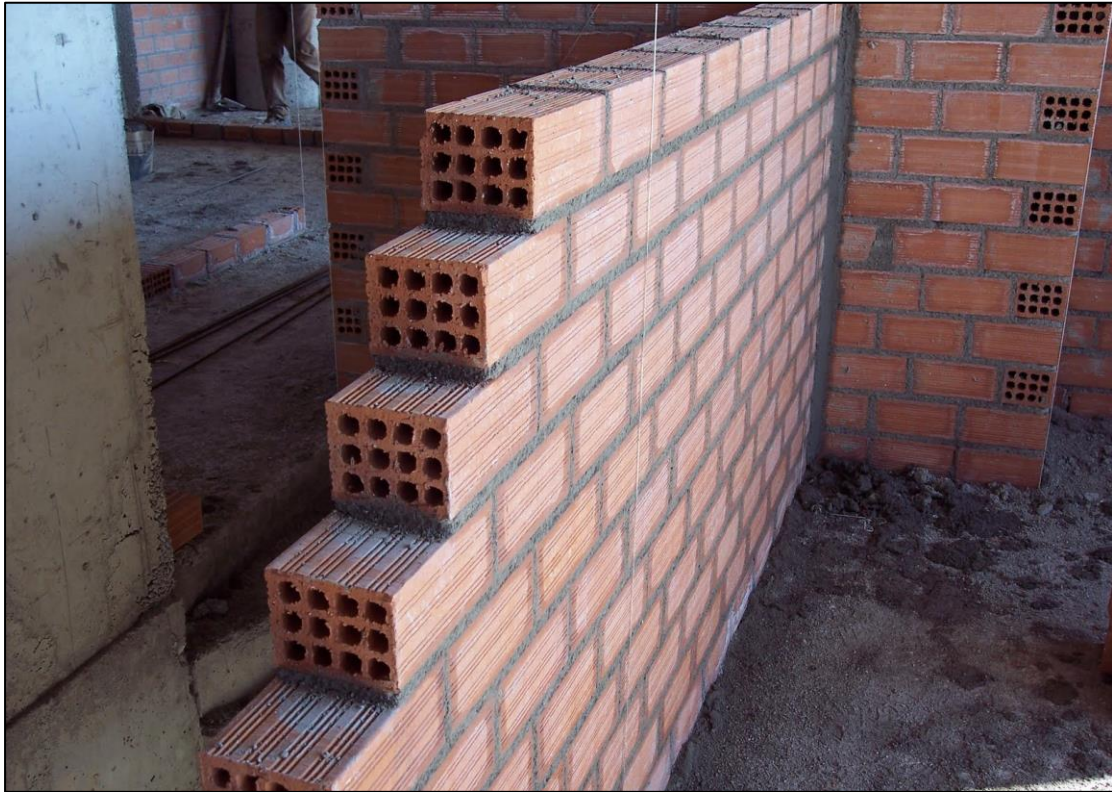
Εικόνα 8: Ενδεικτική φωτογραφία δομικής τοιχοποιίας με 120πο τούβλο (Οικοδόμος, 2011)
