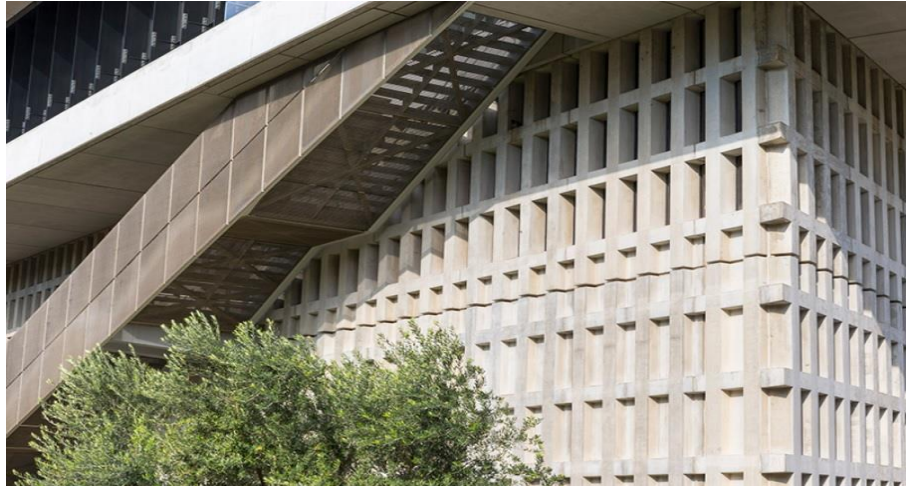
Εικόνα 7-17 Εξωτερική άποψη των πινέλων οπλισμένου σκυροδέματος, στο ισόγειο του μουσείου. (Πηγή : www.designboom.com ) (Ημερομηνία τελευταίας ανάκτησης : 10/12/22)
