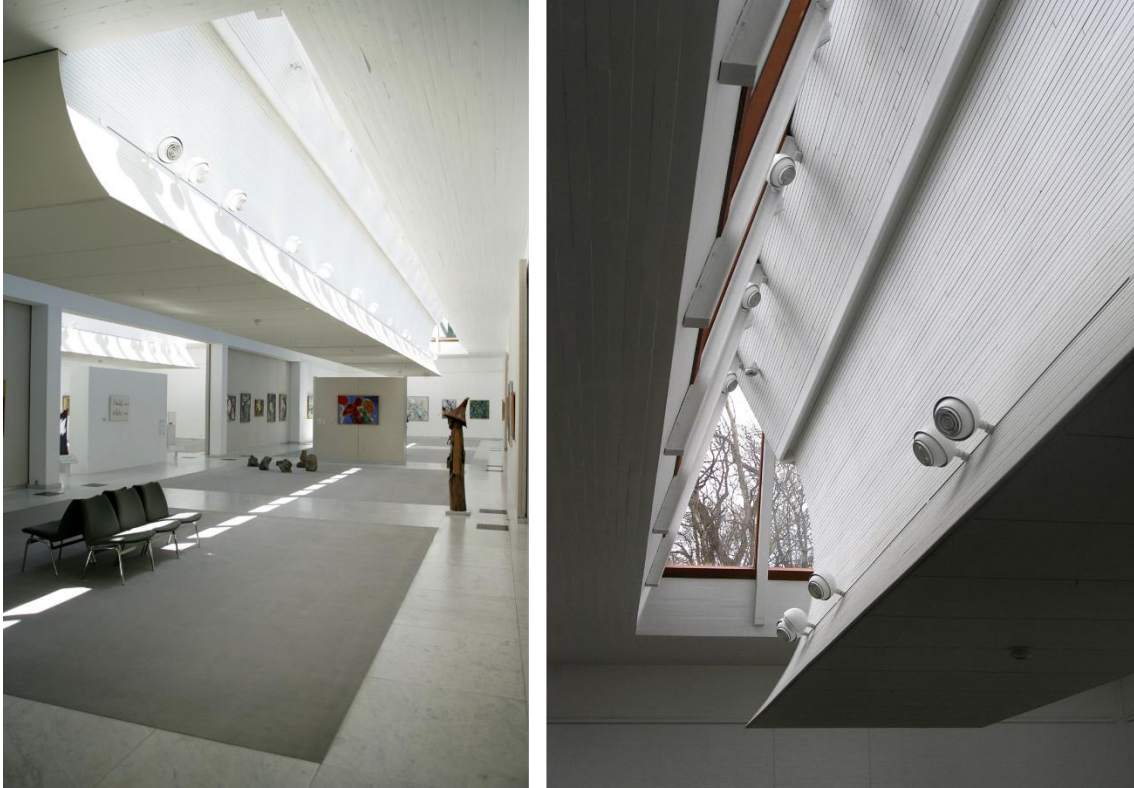
Εικόνα 2-7 Το σύστημα των καμπύλων ανακλαστήρων στο μουσείο KUNSTEN στη Δανία. (Πηγή : www.wikipedia.org ) (Ημερομηνία τελευταίας ανάκτησης : 14/01/22)
