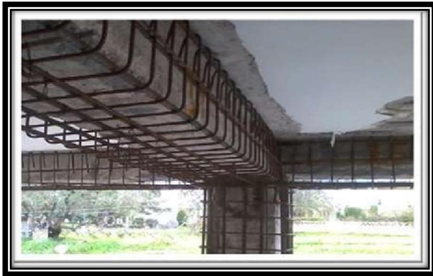
Εικόνα 15: Ενίσχυση κάτω πέλατος δοκών (Βαρδακαστάνης Οικοδομική, 2020)
