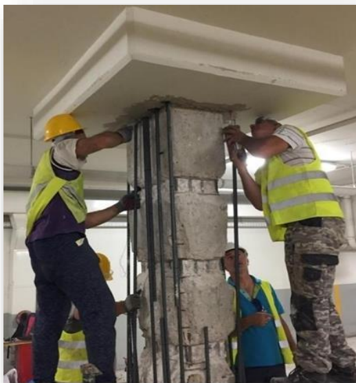
Εικόνα 21: Τοποθέτηση νέων κατακόρυφων οπλισμών μανδύα. Ο μανδύας συνεχίζει και στο ανώτερο υποστύλωμα οπότε και οι ράβδοι διαπερνούν την πλάκα (προσωπικό αρχείο).
