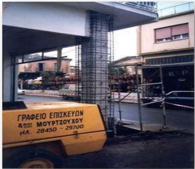
Εικόνα 18: Ενίσχυση υποστυλωμάτων με μανδύες οπλισμένου σκυροδέματος (Πανεπιστήμιο Πατρών, 2020)
