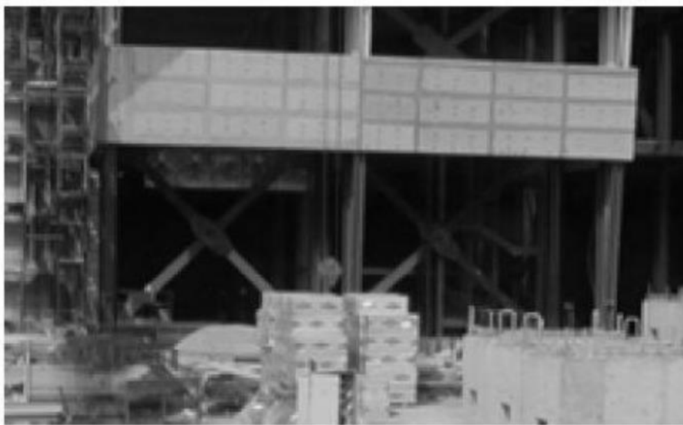
Εικόνα 25: Αντισεισμική ενίσχυση κατασκευής με χιαστί διαγώνιους συνδέσμους
