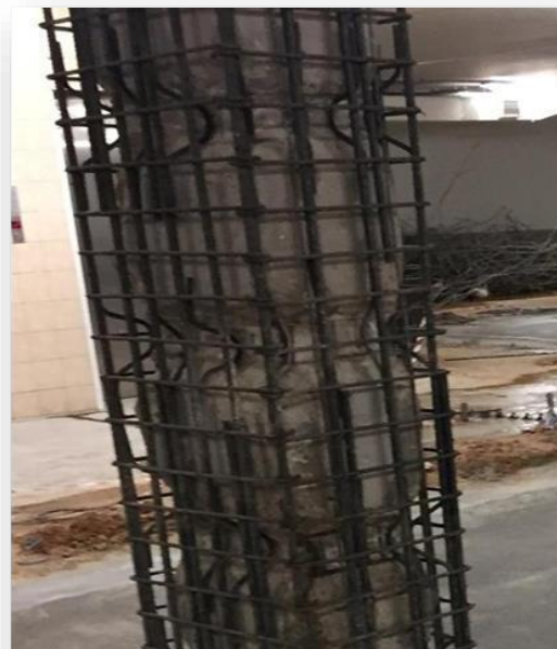
Εικόνα 21: Τοποθέτηση νέων κατακόρυφων οπλισμών μανδύα. Ο μανδύας συνεχίζει και στο ανώτερο υποστύλωμα οπότε και οι ράβδοι διαπερνούν την πλάκα (προσωπικό αρχείο).
