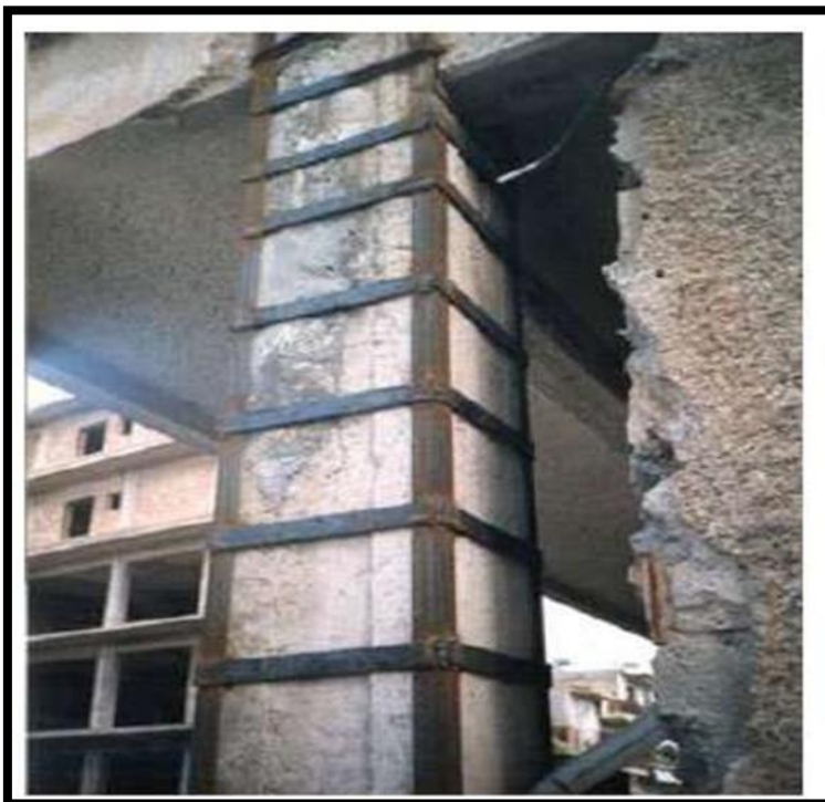
Εικόνα 20: Ενίσχυση υποστυλώματος με χαλύβδινες λάμες (Καϊρης, Χατζηβασιλειάδης, 2008)
