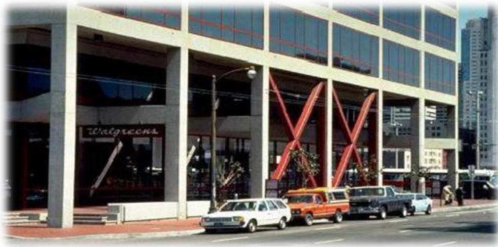
Εικόνα 17: Ενίσχυση με μεταλλικούς συνδέσμους δυσκαμψίας
