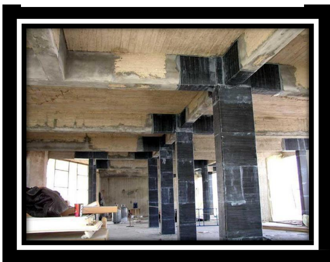
Εικόνα 26: Ενίσχυση δομικών μελών με ινοπλισμένα πολυμερή
