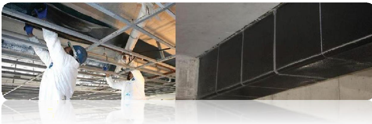
Εικόνα 16: Εφαρμογή υφασμάτων ινοπλισμένων πολυμερών σε δοκό για αύξηση καμπτικής αντοχής αριστερά και καμπτικής & διατμητικής δεξιά (Σφακιανάκης 2018).
