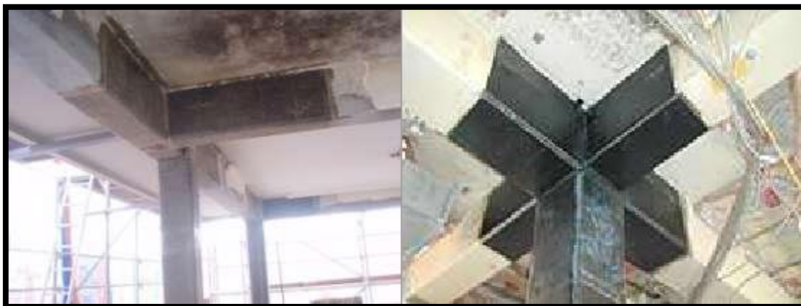
Εικόνα 19: Ενίσχυση υποστυλωμάτων με ΙΟΠ (Δασκαλάκης Τεχνική Κατασκευαστική Μελετητική, 2020)
