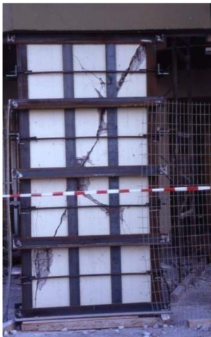
Εικόνα 24: Παράδειγμα προσωρινής ενίσχυσης τοιχώματος ισογείου με μεταλλικό κλωβό
