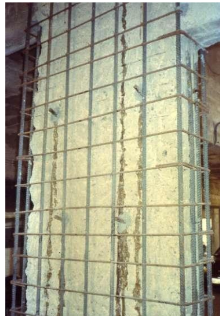
Εικόνα 23: Παράδειγμα προσωρινής ενίσχυσης τοιχώματος ισογείου με μανδύα
